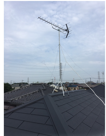
春日部市増富 地デジアンテナ屋根上工事
