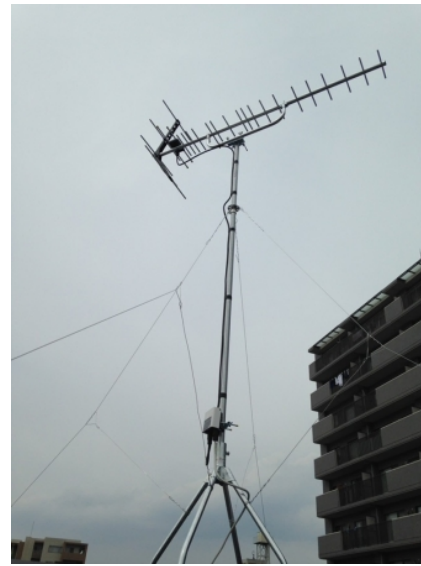
朝霞市三原 地デジアンテナ屋根上工事
