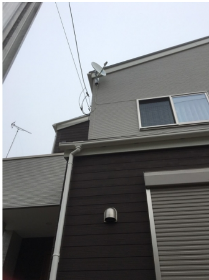
朝霞市根岸台 BSアンテナ工事後の外観
