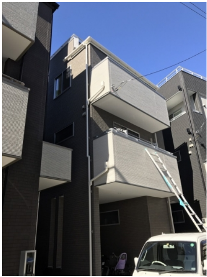
朝霞市栄町 デザインアンテナ工事後の外観
