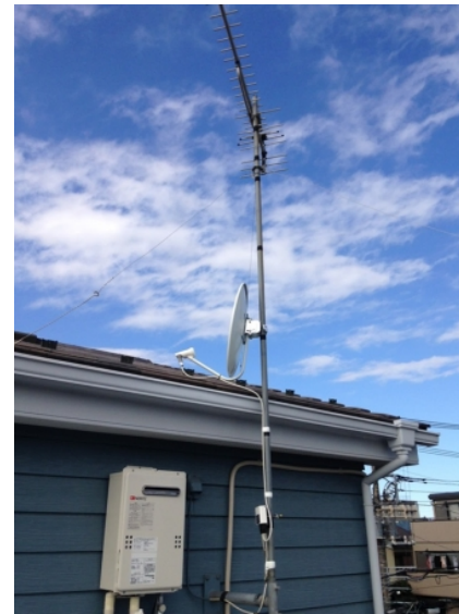
朝霞市根岸台 BSアンテナ追加工事
