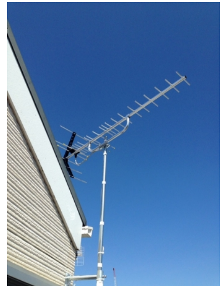
朝霞市溝沼 壁面取付 デザインアンテナ工事
