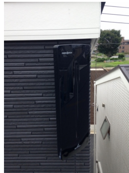
朝霞市根岸台 壁面取付 デザインアンテナ工事
