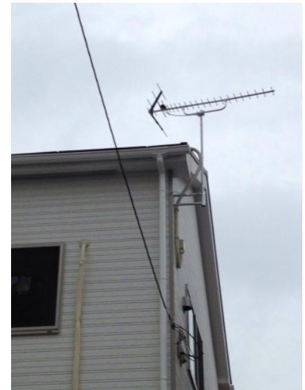
朝霞市泉水 地デジアンテナ工事後の外観
