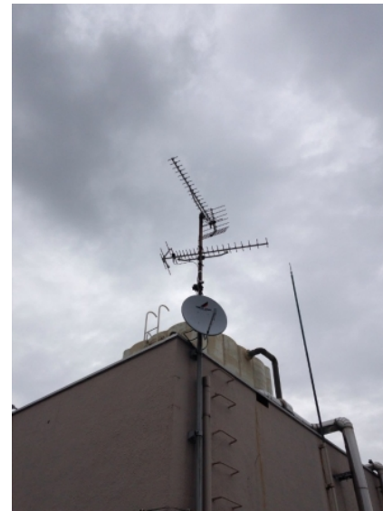
川口市安行領根岸 BSアンテナ交換
