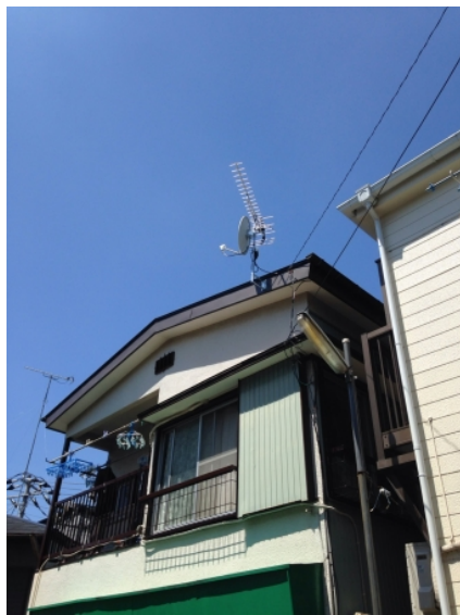
川口市桜町 地デジアンテナとBSアンテナ工事後の外観
