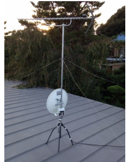
川口市桜町 地デジアンテナとBSアンテナ工事
