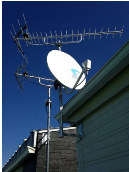
川口市芝塚原 壁面取付 地デジアンテナとBSアンテナ工事
