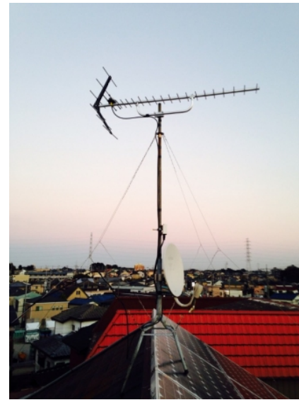
川口市木曽呂 地デジアンテナ追加工事
