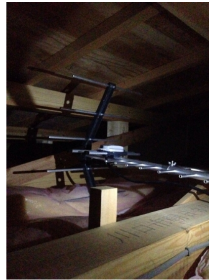
川口市朝日 地デジアンテナ屋根裏工事
