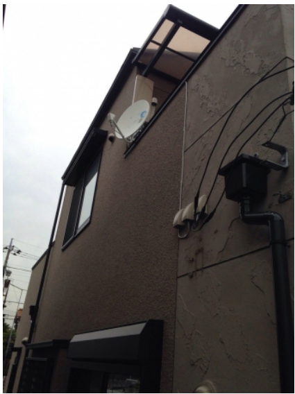
川口市桜町 デザインアンテナとBSアンテナ工事後の外観
