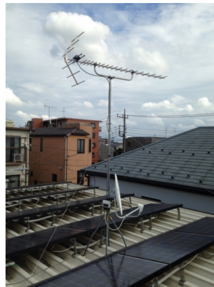
川口市朝日 地デジアンテナとBSアンテナ屋根上工事
