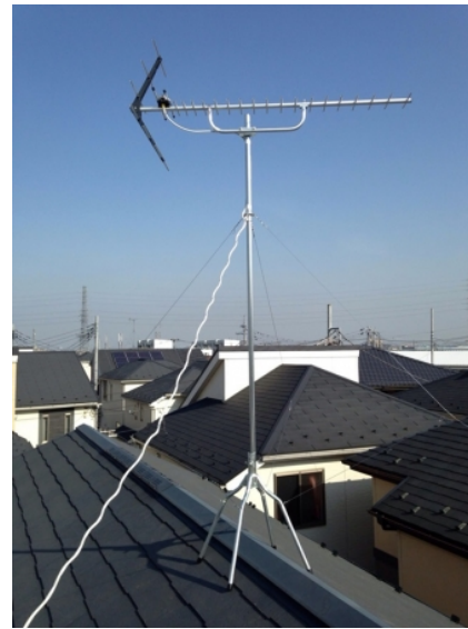
川口市安行吉蔵 地デジアンテナ屋根上工事
