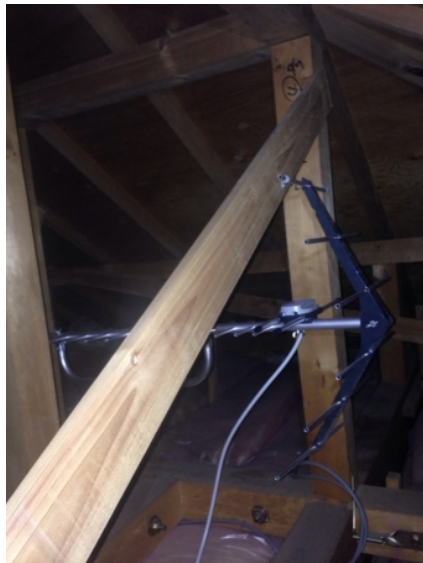
川口市安行出羽 地デジアンテナ屋根裏工事
