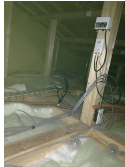
川口市柳崎 地デジアンテナ屋根裏工事
