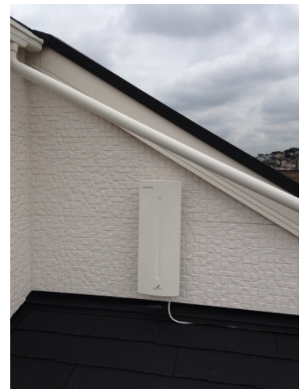
川口市上青木 壁面取付 デザインアンテナ工事
