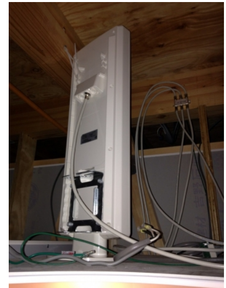
川口市在家町 デザインアンテナ屋根裏工事
