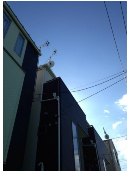
川口市芝塚原 地デジアンテナとBSアンテナ工事後の外観
