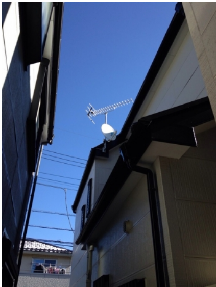
川口市長蔵 地デジアンテナとBSアンテナ工事後の外観
