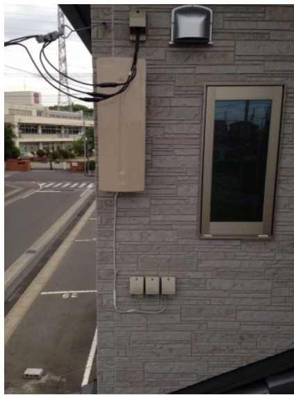
川口市里 壁面取付 デザインアンテナ工事
