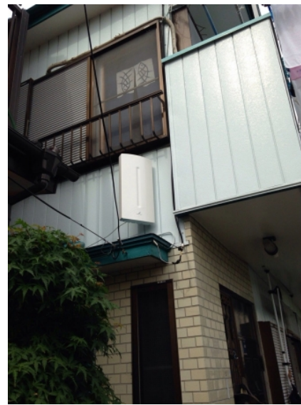
川口市芝 壁面取付 デザインアンテナ工事
