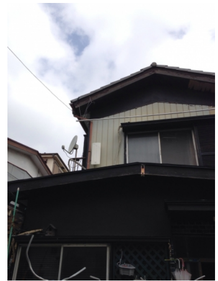
川口市東本郷 デザインアンテナとBSアンテナ工事後の外観
