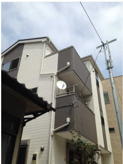
川口市飯塚 BSアンテナ工事後の外観
