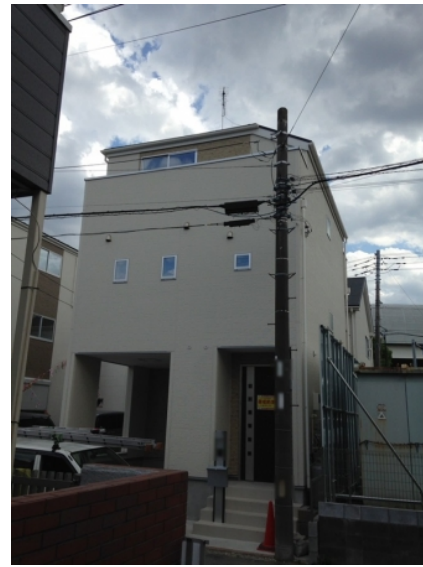
川口市道合 地デジアンテナ工事後の外観
