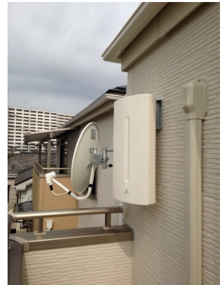
川口市芝樋ノ爪 壁面取付 デザインアンテナとBSアンテナ工事
