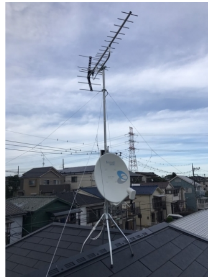
川口市戸塚南 地デジアンテナとBSアンテナ屋根上工事
