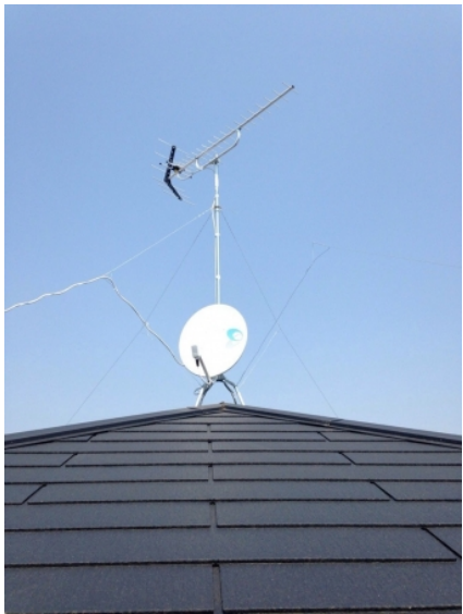
川口市坂下町 地デジアンテナとBSアンテナ屋根上工事
