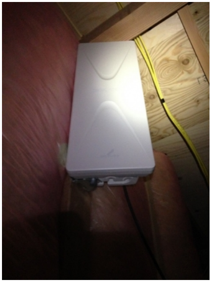
川口市新井町 ポラス様物件 デザインアンテナ屋根裏工事
