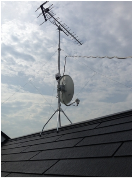
川口市安行原 地デジアンテナとBSアンテナ屋根上工事
