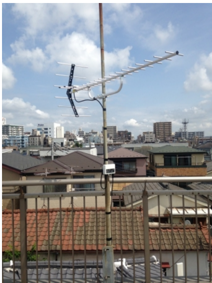
川口市並木 地デジアンテナ追加工事
