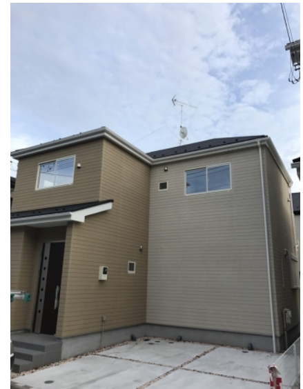
川口市戸塚南 地デジアンテナとBSアンテナ工事後の外観
