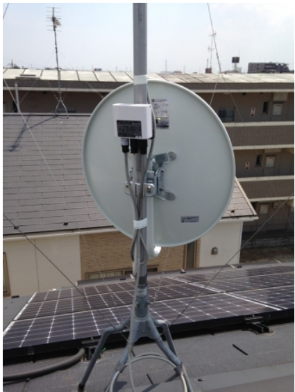
川口市並木北原台 アーネストワン様物件 BSアンテナ追加工事
