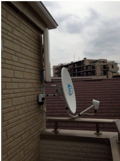
川口市元郷 壁面取付 デザインアンテナとBSアンテナ工事
