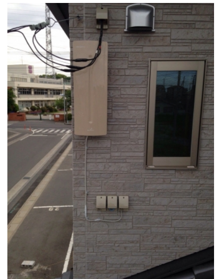
川口市里 壁面取付 デザインアンテナ工事
