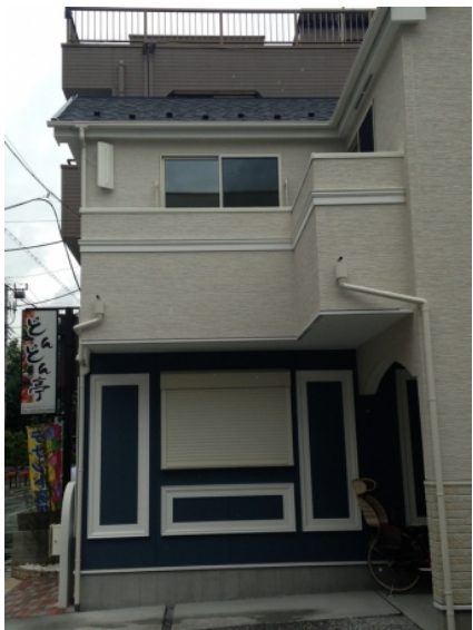
川口市並木 デザインアンテナ工事後の外観
