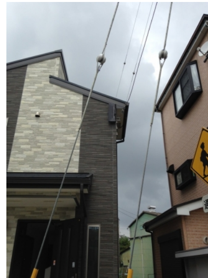
川口市朝日 城南建設様物件 デザインアンテナ工事後の外観
