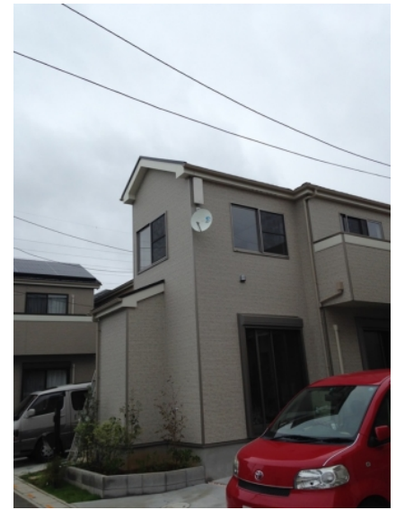
川口市東本郷 飯田産業様物件 デザインアンテナとBSアンテナ工事後の外観
