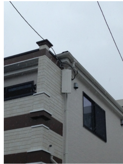
川口市末広 三建アーキテクト様物件 壁面取付 デザインアンテナ工事
