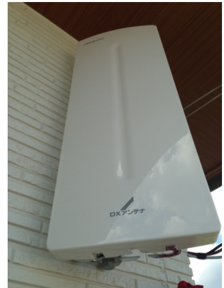
川口市安行出羽 住友林業様物件 壁面取付 デザインアンテナ工事
