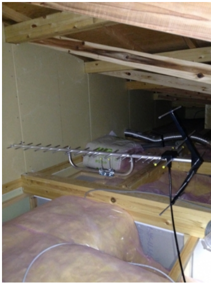
川口市石神 永大様物件 地デジアンテナ屋根裏工事
