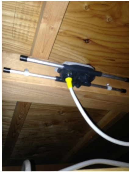
川口市南鳩ヶ谷 アトラスホーム様物件 地デジアンテナ屋根裏工事
