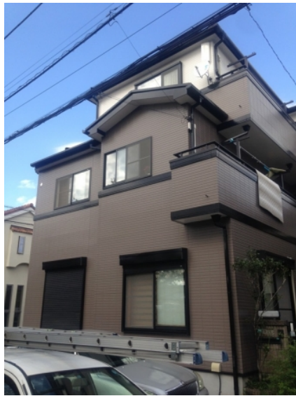
川口市東川口 ポラテック様物件 デザインアンテナとBSアンテナ工事後の外観
