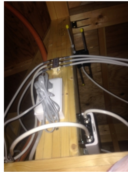
川口市戸塚鉄町 永大様物件 地デジアンテナ屋根裏工事
