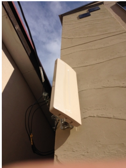
川口市芝 吉岡工務店様物件 壁面取付 デザインアンテナ工事
