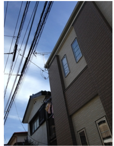
川口市芝 コスモホーム様物件 地デジアンテナ工事後の外観
