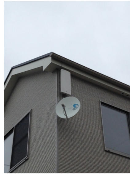
川口市東本郷 飯田産業様物件 壁面取付 デザインアンテナとBSアンテナ工事
