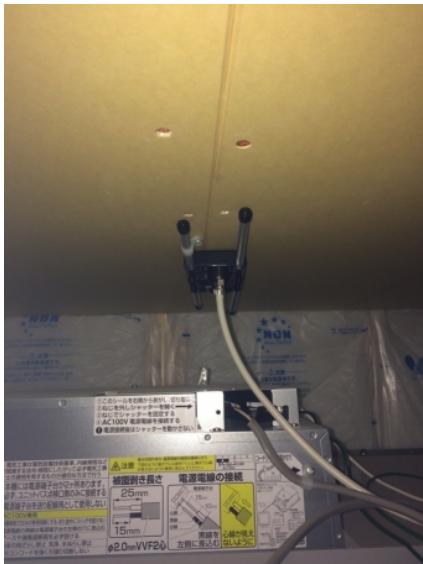
川口市戸塚東 ホークワン様物件 地デジアンテナ屋根裏工事
