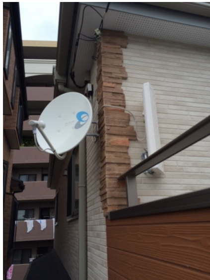
川口市新井宿 共和物産様物件 壁面取付 デザインアンテナとBSアンテナ工事
