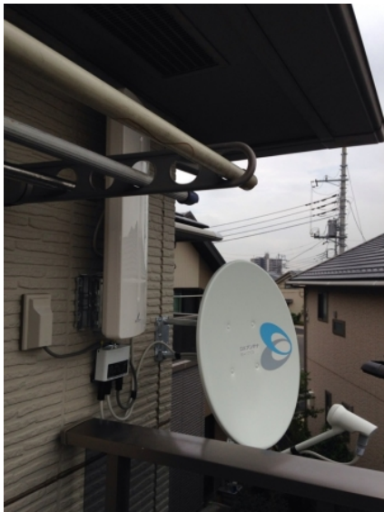
川口市里 ミサワホーム様物件 壁面取付 デザインアンテナとBSアンテナ工事
