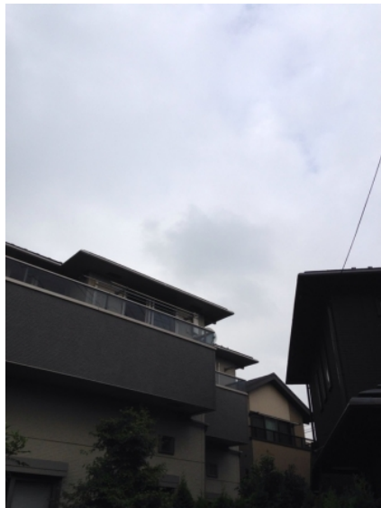
川口市里 ミサワホーム様物件 デザインアンテナとBSアンテナ工事後の外観
