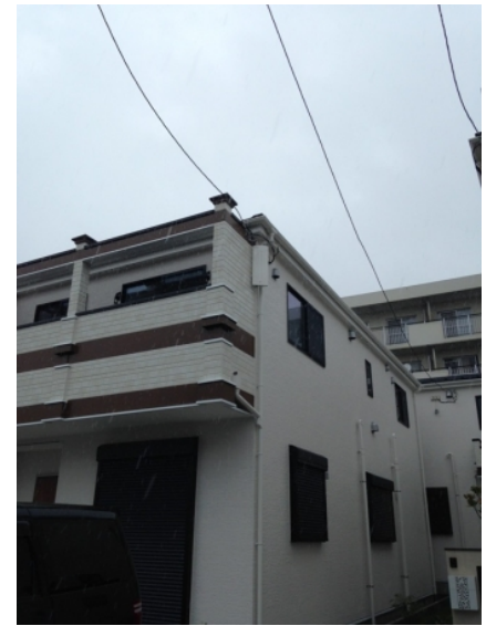
川口市末広 三建アーキテクト様物件 デザインアンテナ工事後の外観
