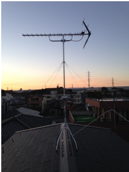
川口市芝西 アベルト様物件 地デジアンテナ屋根上工事
