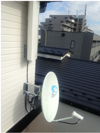
川口市東川口 ポラテック様物件 壁面取付 デザインアンテナとBSアンテナ工事
