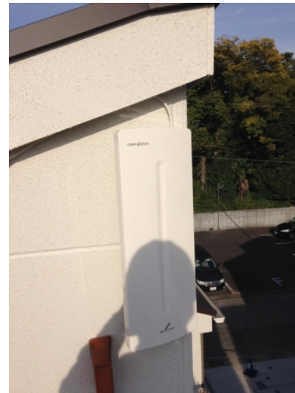
川口市芝塚原 プレストホーム様物件 壁面取付 デザインアンテナ工事
