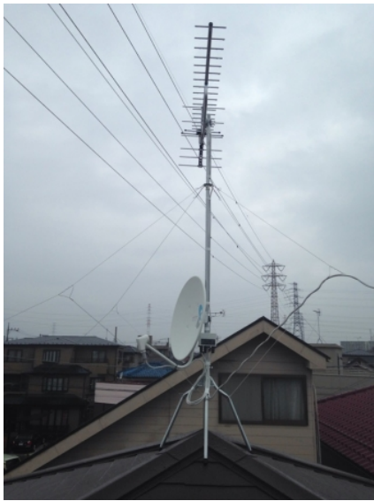
川口市榛松 アイフルホーム様物件 地デジアンテナとBSアンテナ屋根上工事
