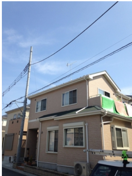
川口市安行領根岸 エース住宅様 地デジアンテナ工事後の外観
