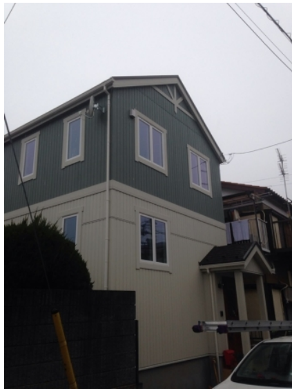
川口市前川町 グッドリビング様物件 壁面取付 BSアンテナ工事後の外観
