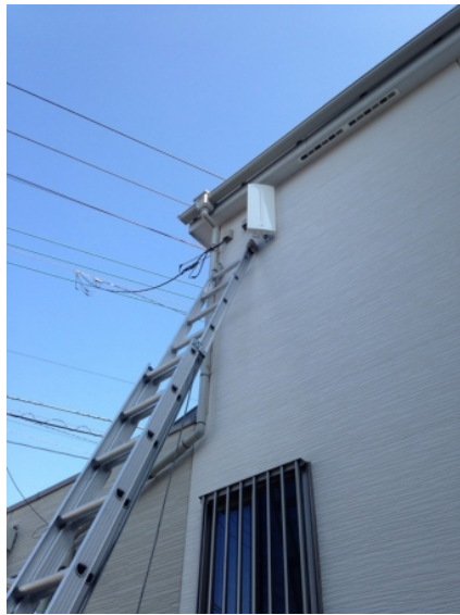
川口市上青木 ホークワン様物件 工事風景
