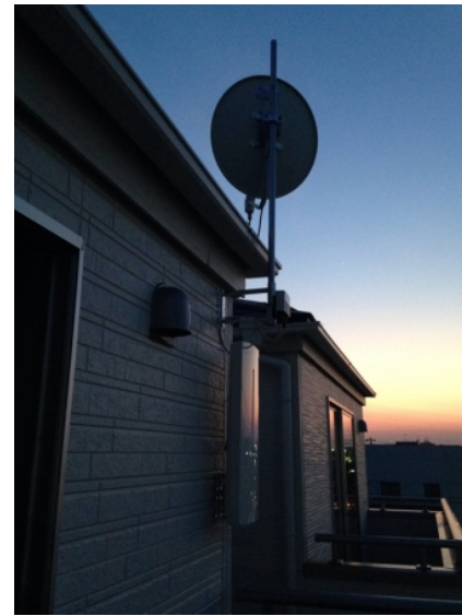
川口市柳根町 一建設様物件 壁面取付 デザインアンテナとBSアンテナ工事
