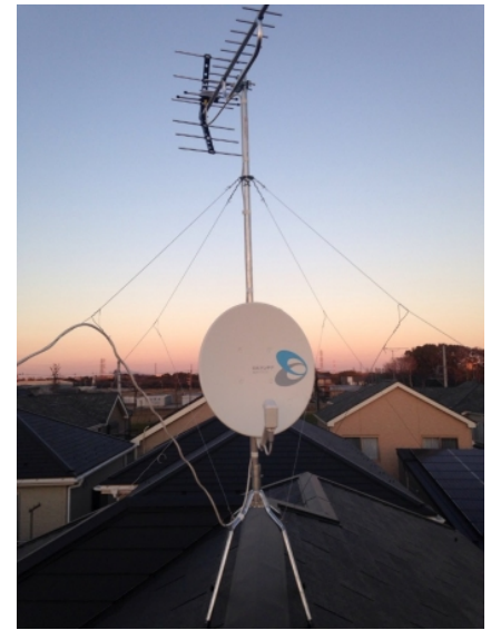
川口市東川口 一建設様物件 地デジアンテナとBSアンテナ屋根上工事
