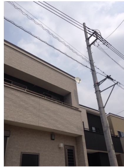
川口市石神 永大様物件 BSアンテナ工事後の外観
