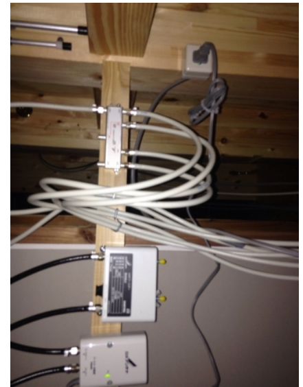
川口市安行原 アーネストワン様物件 ブースター電源部 ブースター本体 5分配器
