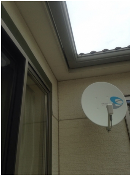
川口市東川口 ポラス様物件 壁面取付 BSアンテナ工事
