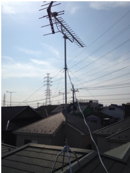
川口市安行領根岸 エース住宅様 地デジアンテナ屋根上工事
