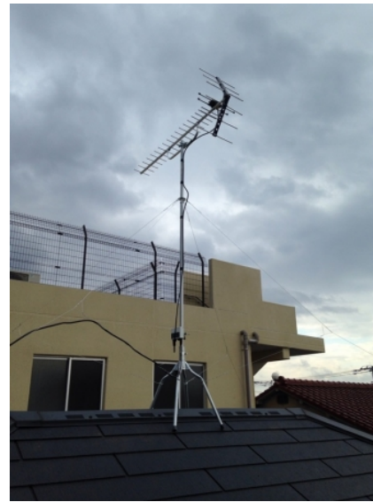
川口市朝日 タクトホーム様物件 地デジアンテナ屋根上工事
