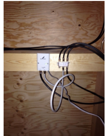
川口市柳根町 一建設様物件 ブースター電源部 5分配器
