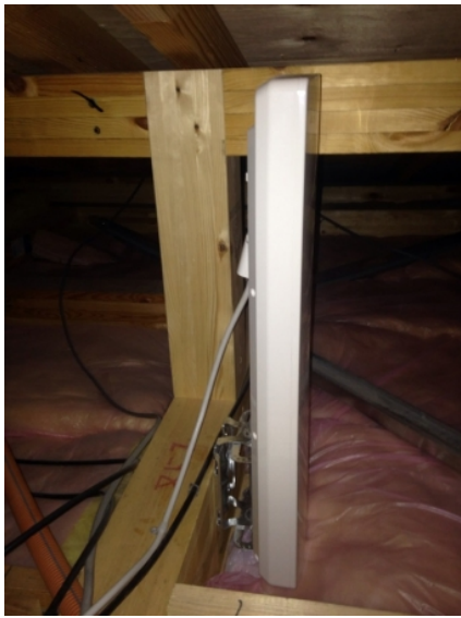
川口市坂下町 永大様物件 デザインアンテナ屋根裏工事
