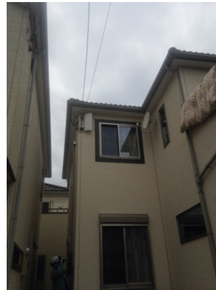
川口市東川口 ポラス様物件 デザインアンテナとBSアンテナ工事後の外観
