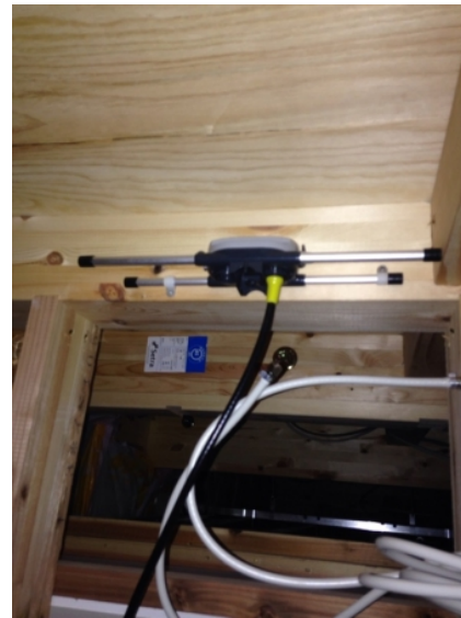
川口市安行原 アーネストワン様物件 地デジアンテナ屋根裏工事
