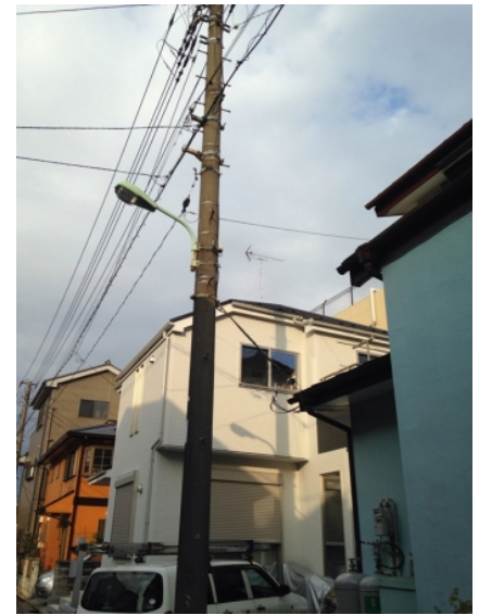
川口市朝日 タクトホーム様物件 地デジアンテナ工事後の外観
