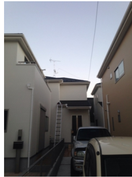
川口市東川口 一建設様物件 地デジアンテナとBSアンテナ工事後の外観
