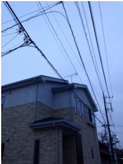
川口市東本郷 城南建設様物件 地デジアンテナ工事後の外観
