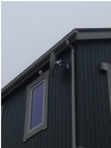
川口市前川町 グッドリビング様物件 壁面取付 BSアンテナ工事
