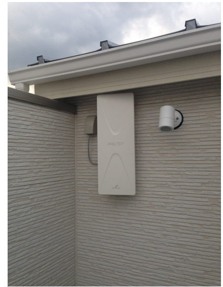
川口市芝新町 壁面取付 デザインアンテナ工事
