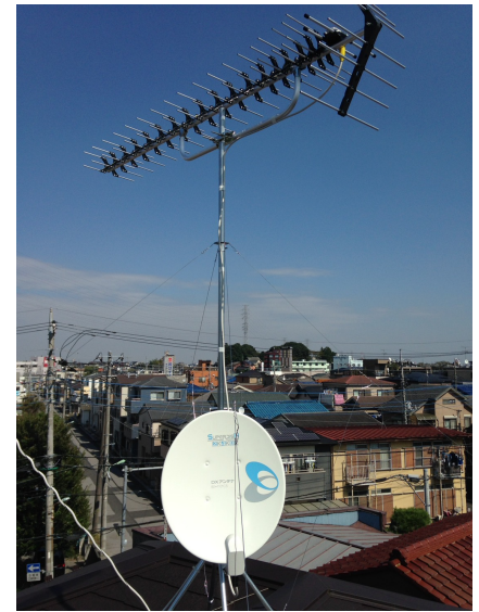
川口市芝 コスモホーム様物件 地デジアンテナとBSアンテナ屋根上工事
