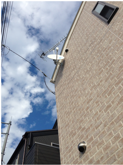
川口市安行原 地デジアンテナとBSアンテナ工事
