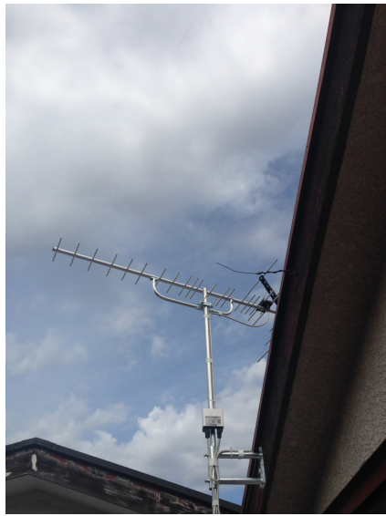
川口市桜町 地デジアンテナ工事
