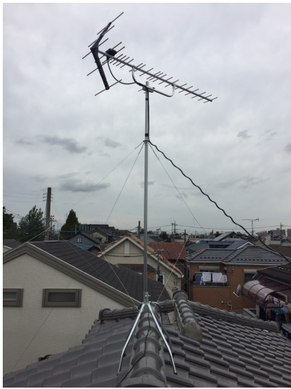
川口市南鳩ヶ谷 地デジアンテナ屋根上工事
