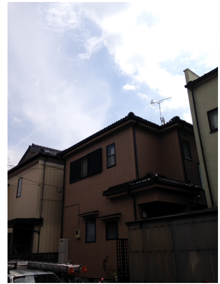
川口市赤井 地デジアンテナとBSアンテナ工事後の外観
