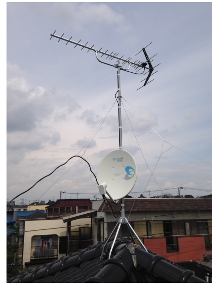
川口市赤井 地デジアンテナとBSアンテナ屋根上工事
