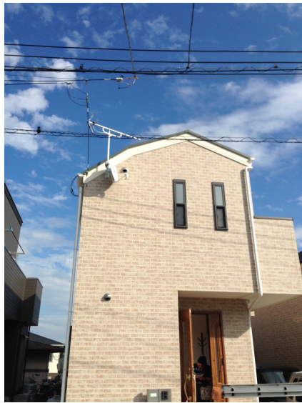
川口市安行原 地デジアンテナとBSアンテナ工事後の外観
