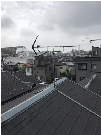
川口市鳩ヶ谷緑町 地デジアンテナ工事
