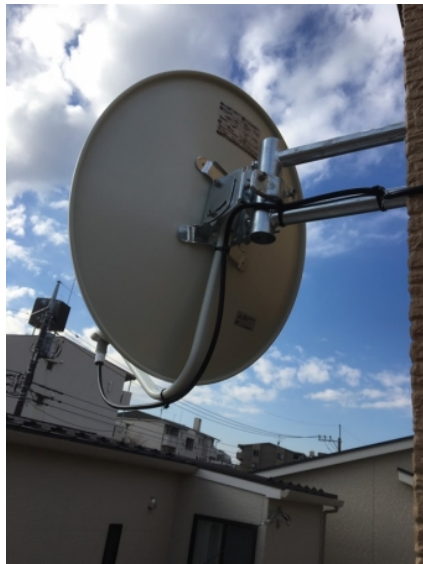
川口市北原台 ポラス様物件 壁面取付 BSアンテナ工事
