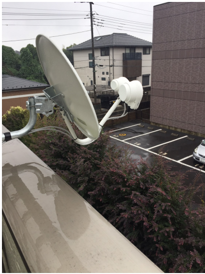
川口市西立野 BSアンテナ工事
