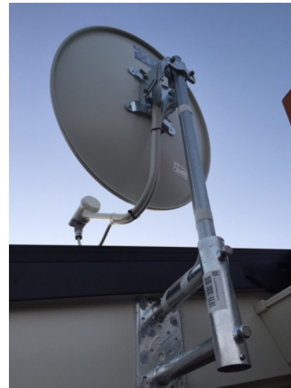
川口市戸塚 一条工務店様物件 壁面取付 BSアンテナ工事
