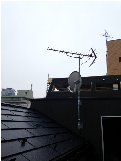
川口市芝新町 壁面設置 地デジアンテナとBSアンテナ工事
