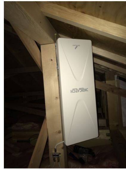
川口市青木 デザインアンテナ屋根裏工事
