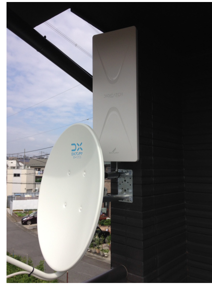
川口市戸塚南 壁面取付 デザインアンテナとBSアンテナ工事
