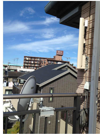
川口市鳩ヶ谷 セクスイハイム様物件 デザインアンテナとBSアンテナ工事
