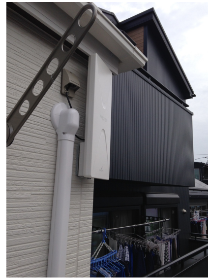
川口市南町 ライジングホーム様物件 壁面取付 デザインアンテナ工事
