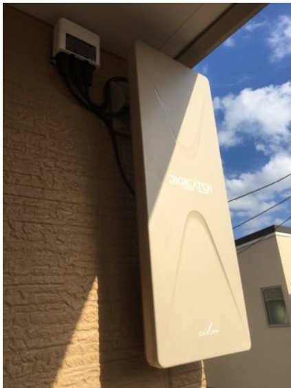
川口市北原台 ポラス様物件 壁面取付 デザインアンテナ工事
