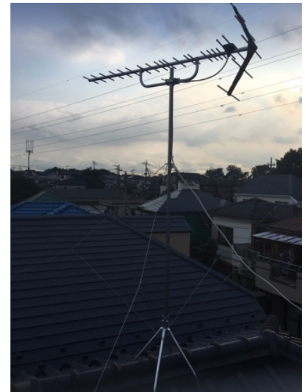
川口市南内野 地デジアンテナ屋根上工事
