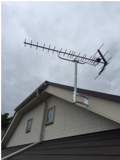
川口市桜町 壁面取付 地デジアンテナ工事
