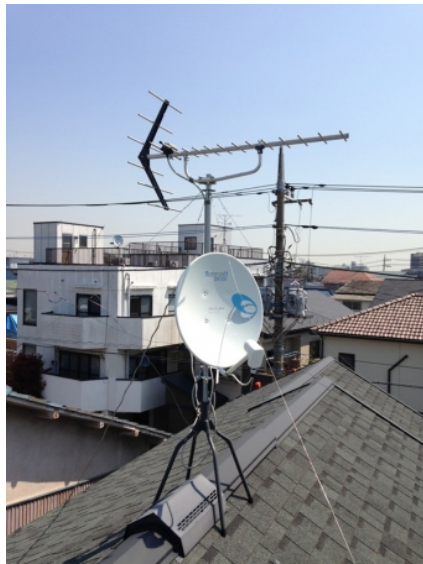
川口市領家 BSアンテナ追加工事
