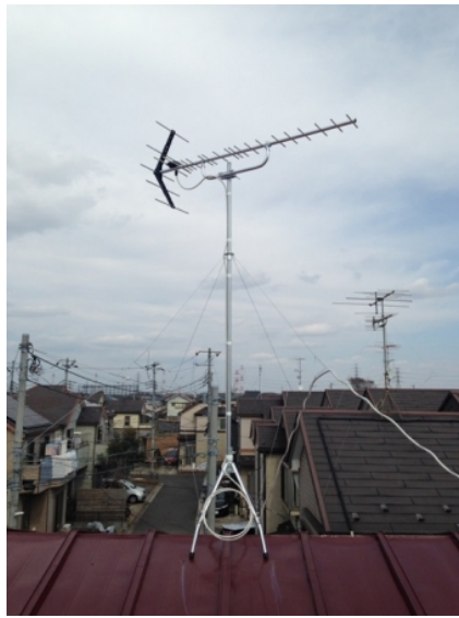
川口市安行原 地デジアンテナ屋根上工事
