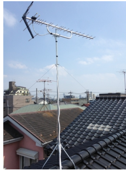
川口市上青木西 地デジアンテナ屋根上工事
