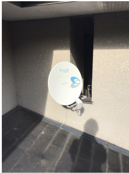
川口市西新井宿 壁面取付 B S アンテナ工事
