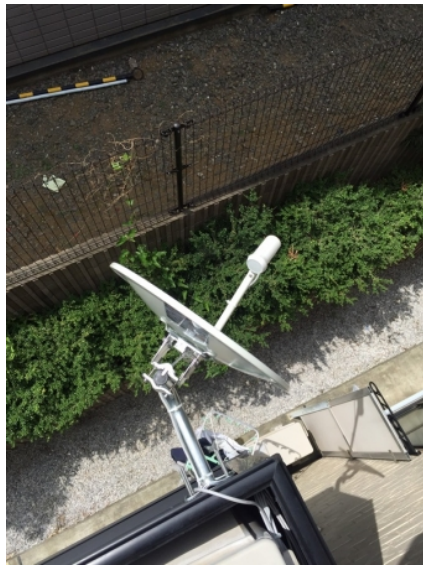
川口市源左衛門新田 BSアンテナ工事
