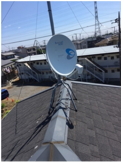
川口市木曽呂 BSアンテナ追加工事
