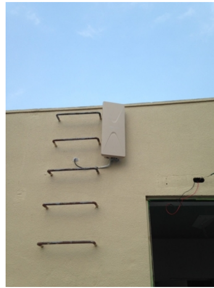
川口市金山町 壁面取付 デザインアンテナ工事
