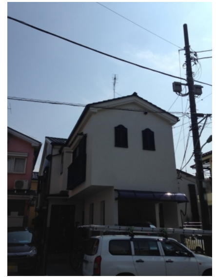
川口市上青木西 地デジアンテナ工事後の外観
