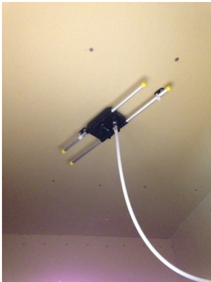
川口市峯 地デジアンテナ屋根裏工事
