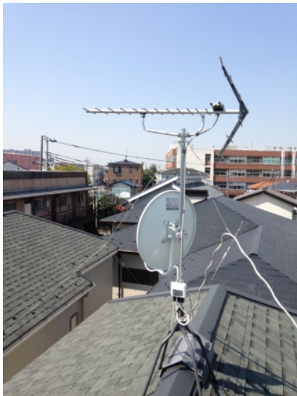
川口市領家 BSアンテナ追加工事
