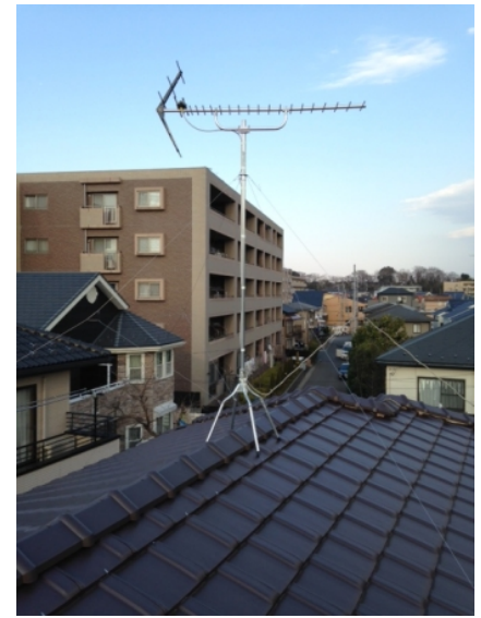
川口市戸塚 地デジアンテナ屋根上工事
