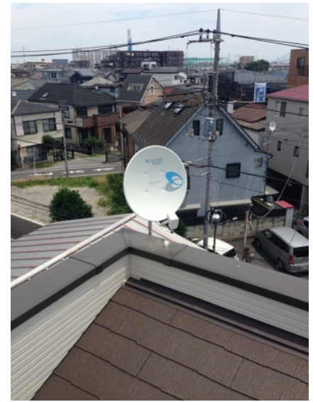
川口市朝日 壁面取付 BSアンテナ工事
