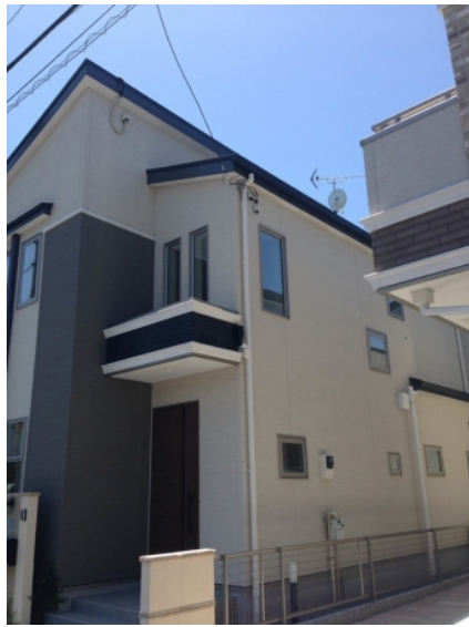
川口市朝日 地デジアンテナとBSアンテナ工事後の外観
