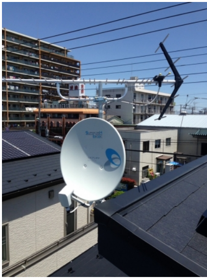
川口市朝日 壁面取付 地デジアンテナとBSアンテナ工事
