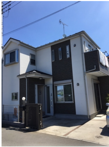
川口市木曽呂 BSアンテナ追加工事後の外観
