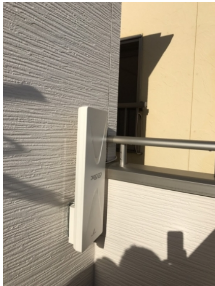
川口市芝下 壁面取付 デザインアンテナ工事
