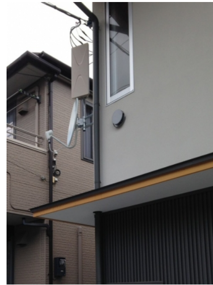
川口市峯 壁面取付 デザインアンテナとBSアンテナ工事
