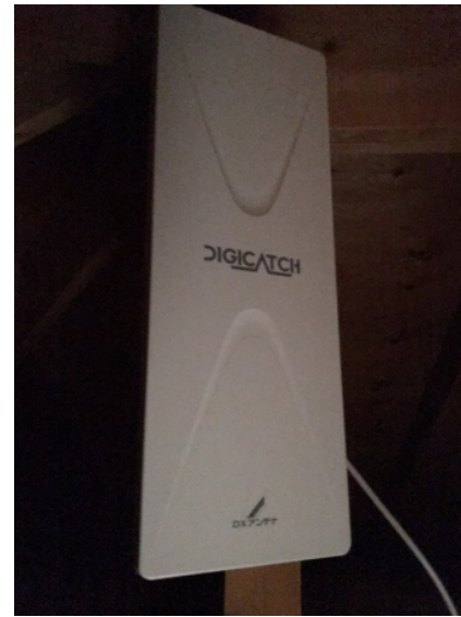
川口市出羽町 デザインアンテナ屋根裏工事
