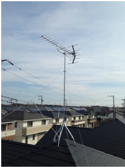
川口市峯 地デジアンテナ追加工事
