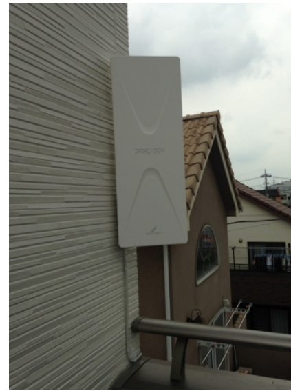
川口市上青木 壁面取付 デザインアンテナ工事
