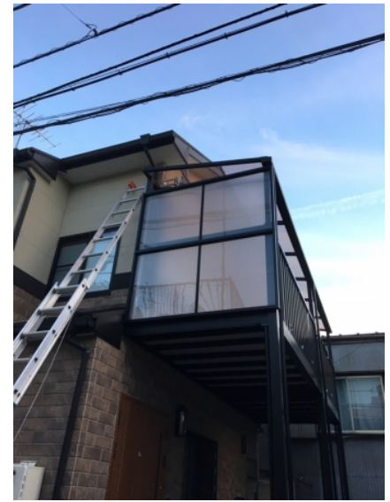
川口市鳩ヶ谷 BSアンテナ工事後の外観
