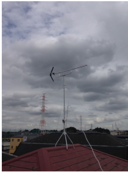
川口市道合 地デジアンテナ屋根上工事
