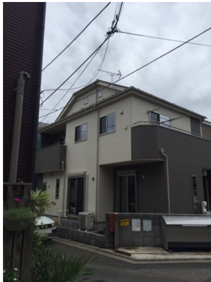
川口市桜町 地デジアンテナ工事後の外観
