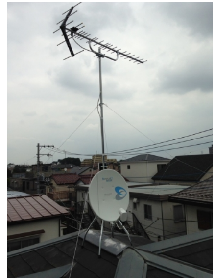
川口市芝 地デジアンテナとB S アンテナ屋根上工事
