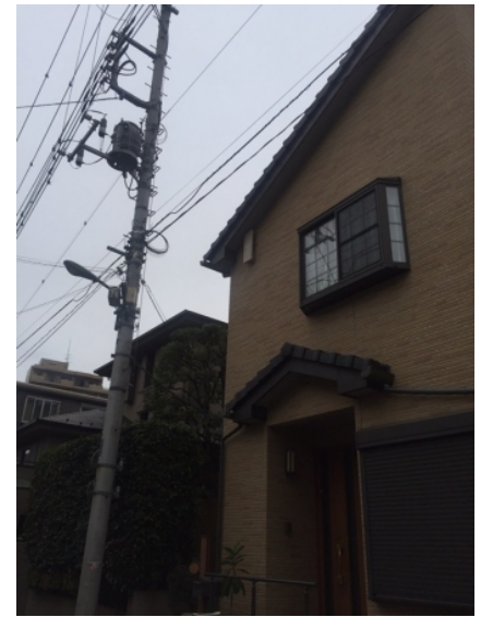
川口市川口 デザインアンテナ工事後の外観
