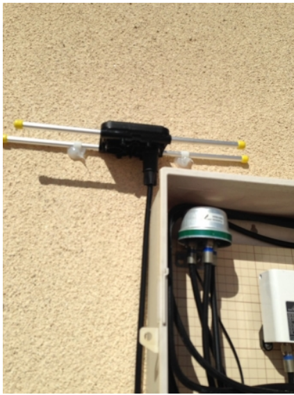
川口市上青木 壁面取付 地デジアンテナ工事
