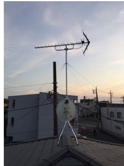
川口市柳崎 地デジアンテナとBSアンテナ屋根上工事
