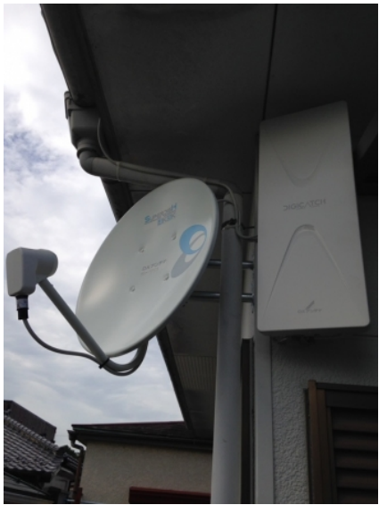
川口市芝 壁面取付 デザインアンテナとB S アンテナ工事
