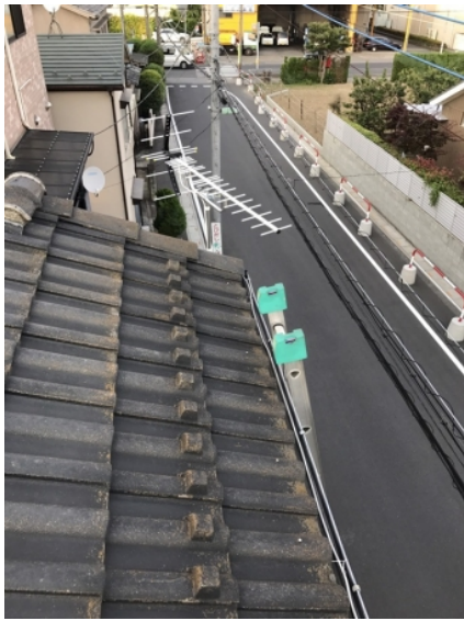
川口市峯 壁面取付 地デジアンテナ工事
