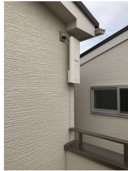
川口市差間 壁面取付 デザインアンテナ工事
