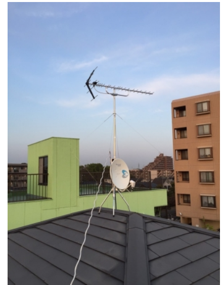
川口市柳崎 地デジアンテナとBSアンテナ屋根上工事
