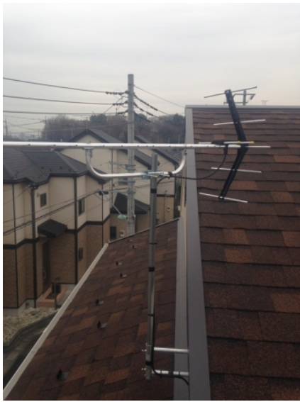
川口市峰 壁面取付 地デジアンテナ工事
