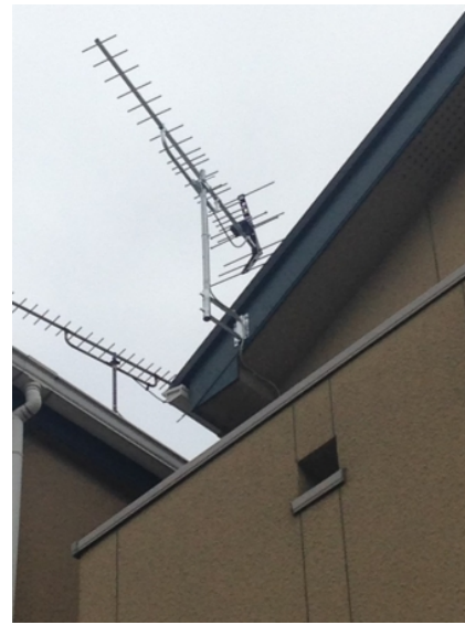
川口市柳橋 壁面取付 地デジアンテナ工事
