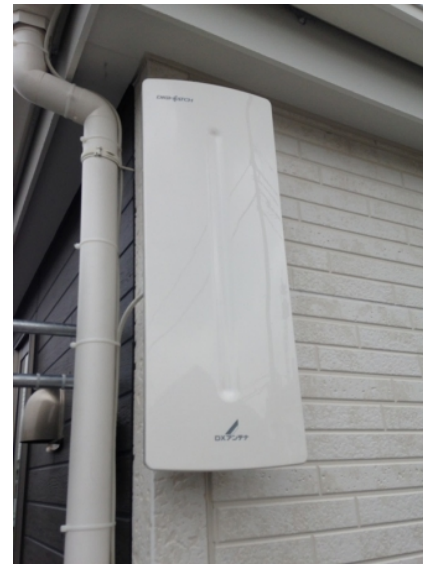
川口市安行原 壁面取付 デザインアンテナ工事
