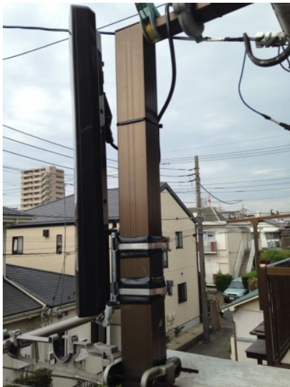
川口市芝 バランダ取付 デザインアンテナ工事
