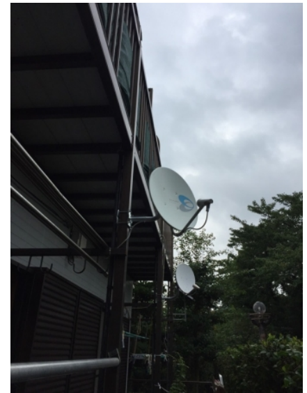
川口市安行 B S アンテナ工事
