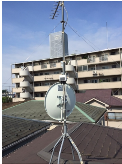
川口市北原台 BSアンテナ追加工事
