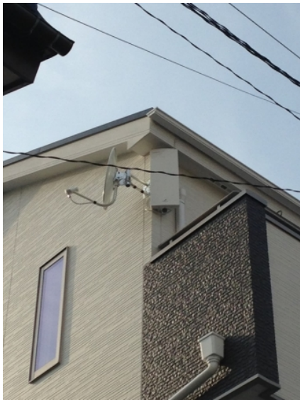
川口市宮町 壁面取付 デザインアンテナとBSアンテナ工事
