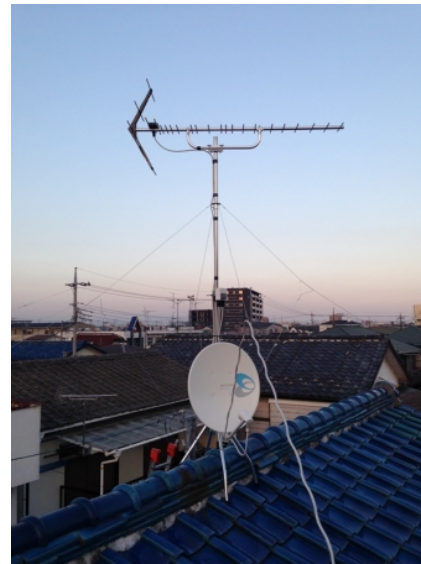
川口市芝樋ノ爪 地デジアンテナとBSアンテナ屋根上工事
