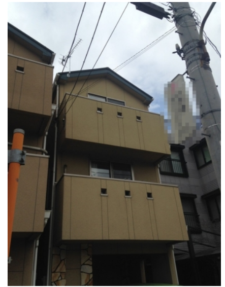
川口市柳橋 地デジアンテナ工事後の外観
