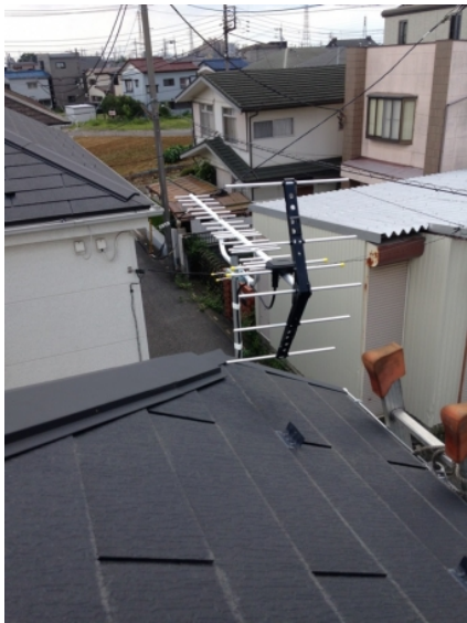
川口市榛松 壁面取付 地デジアンテナ工事
