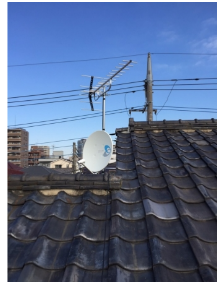
川口市飯塚 壁面取付 地デジアンテナとB S アンテナ工事
