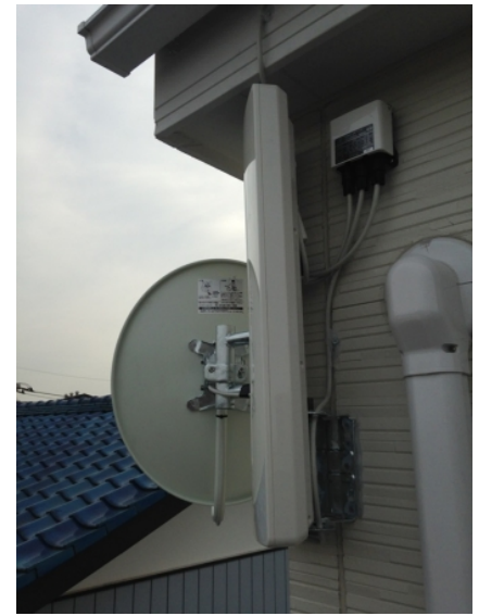
川口市宮町 壁面取付 デザインアンテナとBSアンテナ工事
