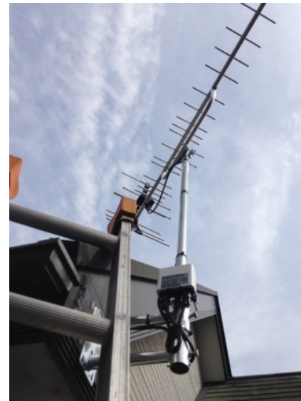
川口市朝日 壁面取付 地デジアンテナ工事
