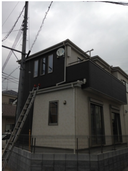
川口市安行原 デザインアンテナとBSアンテナ工事後の外観
