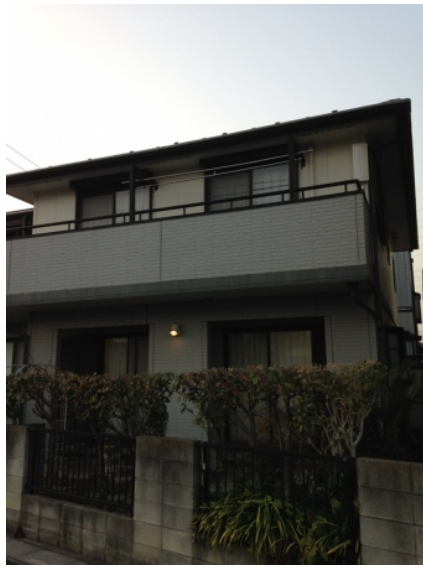
川口市前川町 デザインアンテナ工事後の外観
