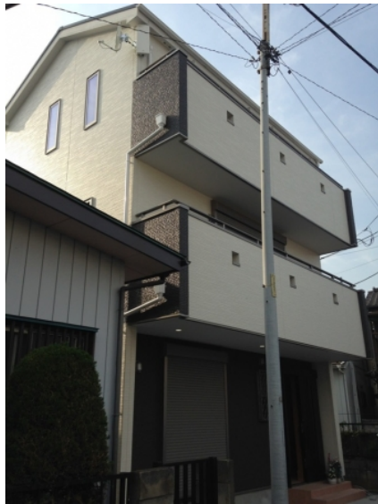
川口市宮町 デザインアンテナとBSアンテナ工事後の外観
