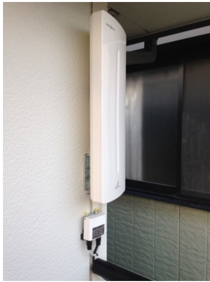
川口市前川町 壁面取付 デザインアンテナ工事
