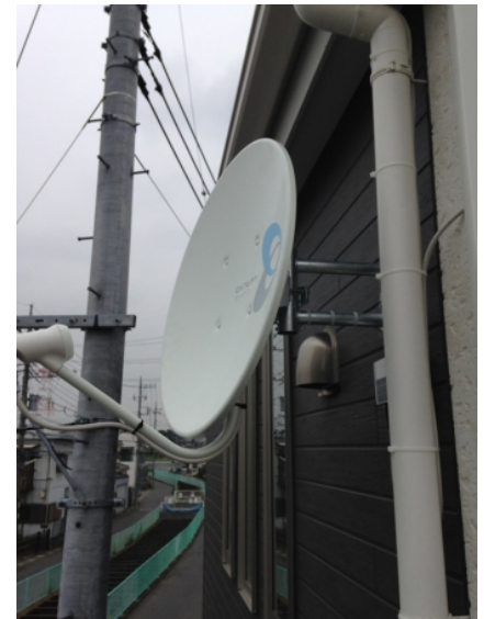
川口市安行原 壁面取付 BSアンテナ工事
