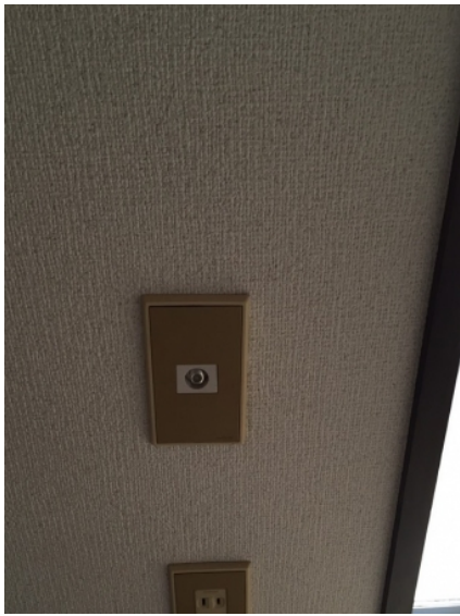
川口市安行領家岸 端子交換工事
