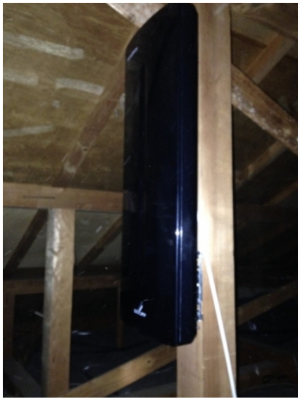
川口市東内野 デザインアンテナ屋根裏工事
