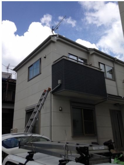
川口市榛松 地デジアンテナ工事後の外観
