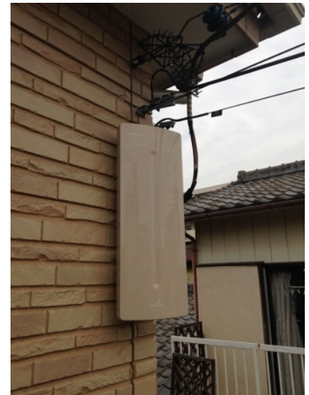
川口市青木 壁面取付 デザインアンテナ工事
