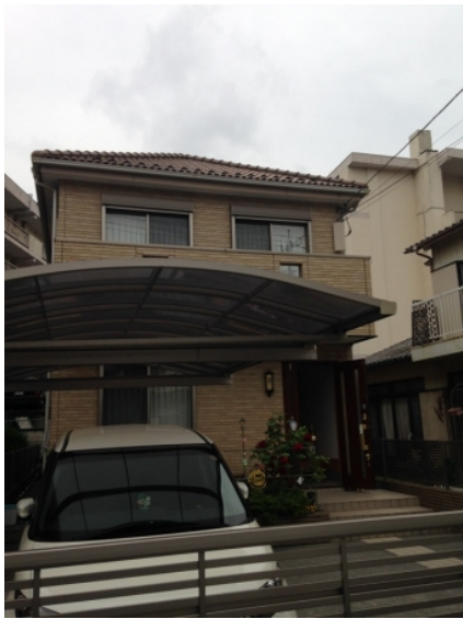
川口市青木 デザインアンテナ工事後の外観
