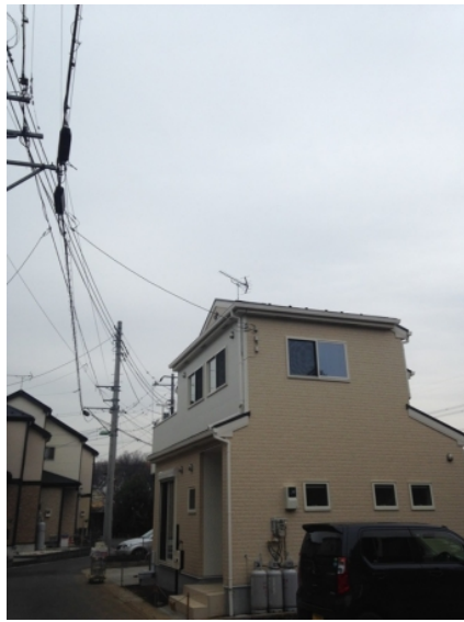
川口市峰 地デジアンテナ工事後の外観
