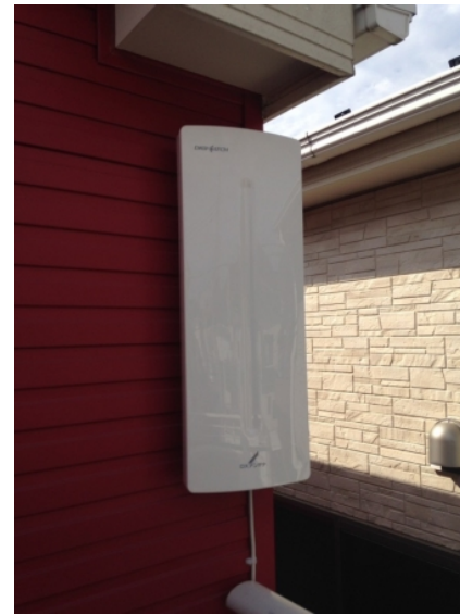
川口市赤井 壁面取付 デザインアンテナ工事
