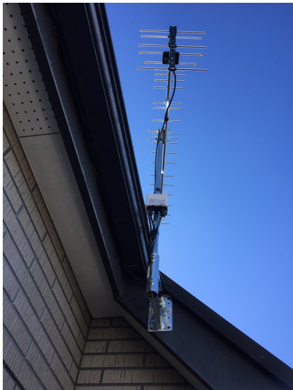
川口市安行領根岸 地デジアンテナ工事
