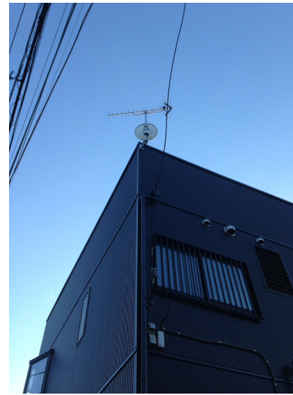
川口市桜町 五十嵐工務店様ご物件 壁面取付 八木式アンテナとBS/CSアンテナ工事
