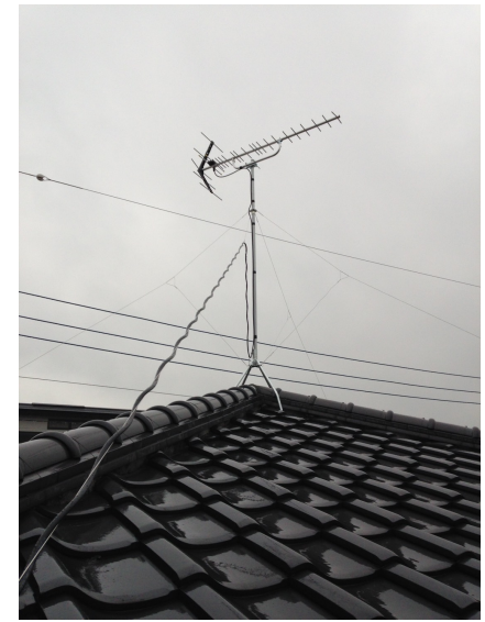
川口市芝 屋根上設置 八木式アンテナ工事
