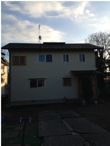
川口市芝 地デジアンテナとBSアンテナ工事後の外観
