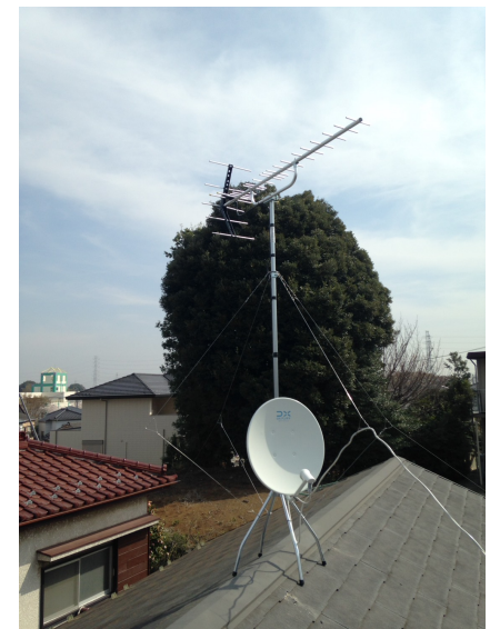
川口市木曽呂 屋根上設置 八木式アンテナとBS/CSアンテナ工事
