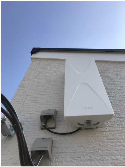
川口市峰 中央建設様ご物件 壁面取付 デザインアンテナ工事
