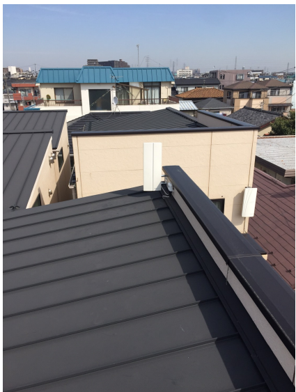
川口市朝日 壁面取付 デザインアンテナ工事
