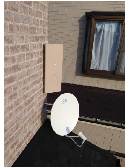
川口市南前川 住宅情報館様物件 壁面取付 デザインアンテナとBSアンテナ工事
