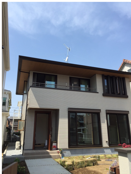
川口市柳崎 積水ハウス様ご物件 八木式アンテナとBSアンテナ工事後の外観
