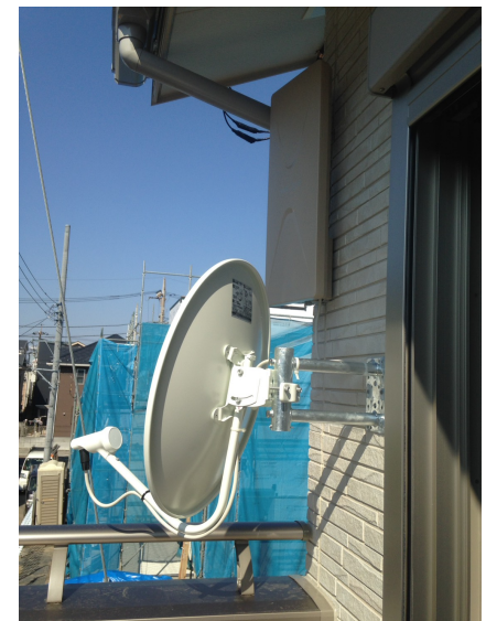
川口市南町 ヤマトサービス様ご物件 壁面取付 デザインアンテナとBS/CSアンテナ工事
