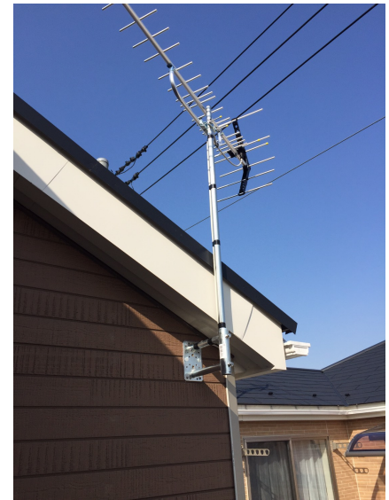
川口市上青木 壁面取付 八木式アンテナ工事
