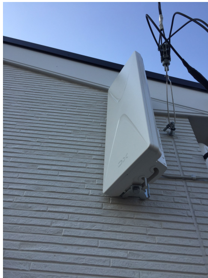
川口市東川口 ホークワン様ご物件 壁面取付 デザインアンテナ工事
