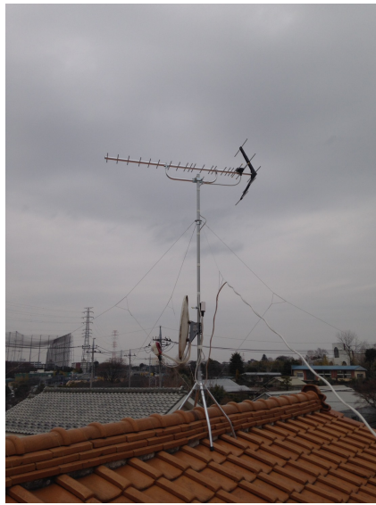
川口市新井宿 屋根上設置 八木式アンテナとBS/CSアンテナ工事
