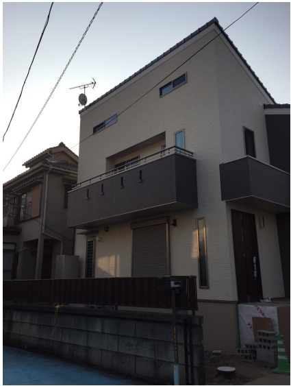
川口市安行藤八 アエラホーム様ご物件 デザインアンテナとBSアンテナ工事後の外観
