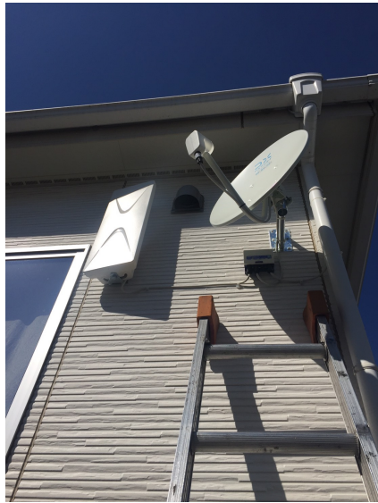
川口市東本郷 一建設様ご物件 壁面取付 デザインアンテナとBS/CSアンテナ工事
