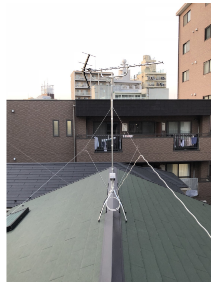
川口市芝新町 ヤマトサービス様ご物件 屋根上設置 八木式アンテナ工事
