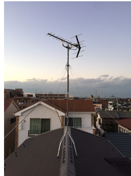
川口市戸塚東 地デジアンテナ屋根上工事
