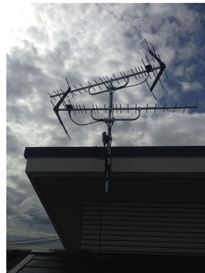
川口市西立野 一条工務店様ご物件 U/U混合八木式アンテナ工事
