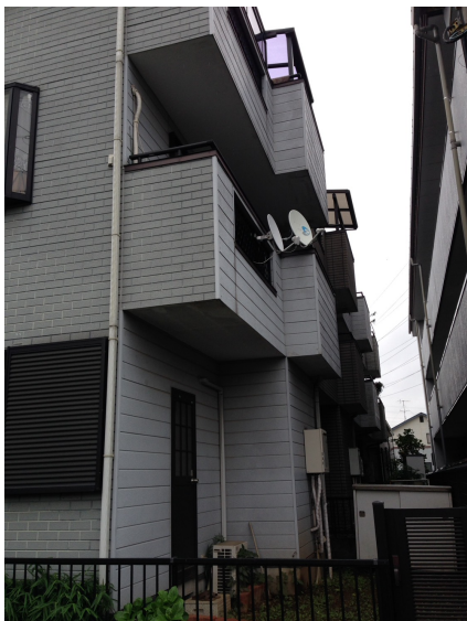
川口市里 BSアンテナ工事後の外観
