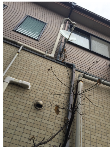
川口市柳崎 壁面取付 BSアンテナ工事
