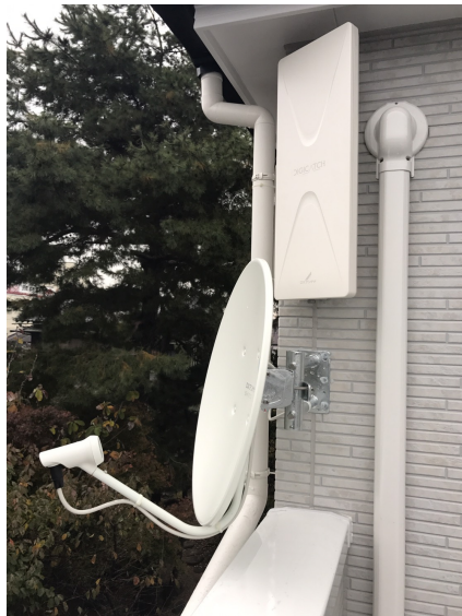
川口市上青木 壁面取付 デザインアンテナとBSアンテナ工事
