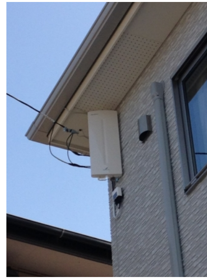
四街道市和良比 広島建設様物件 壁面取付 デザインアンテナ工事
