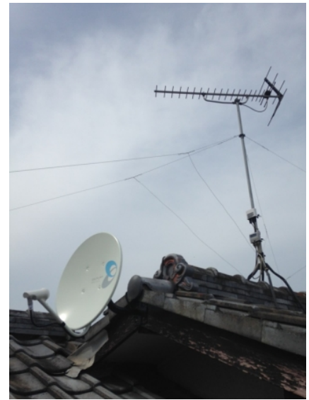
四街道市みそら 壁面取付 BSアンテナ工事
