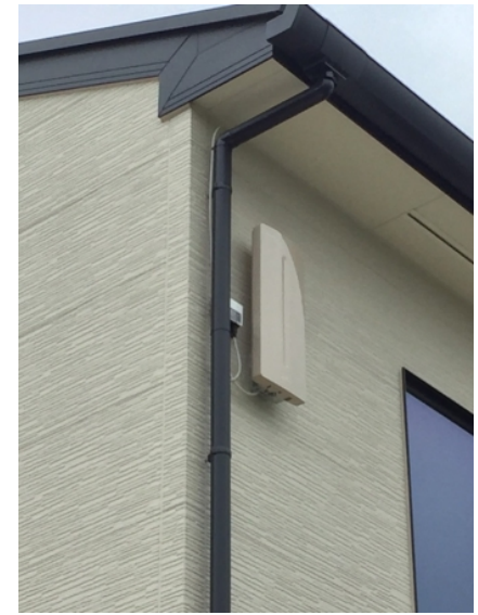
四街道市もねの里 東海住宅様物件 壁面取付 デザインアンテナ工事
