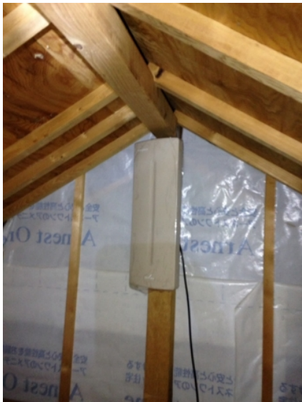
四街道市大日 デザインアンテナ屋根裏工事
