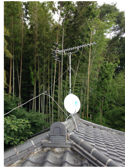
野田市大殿井 地デジアンテナとBSアンテナ屋根上工事
