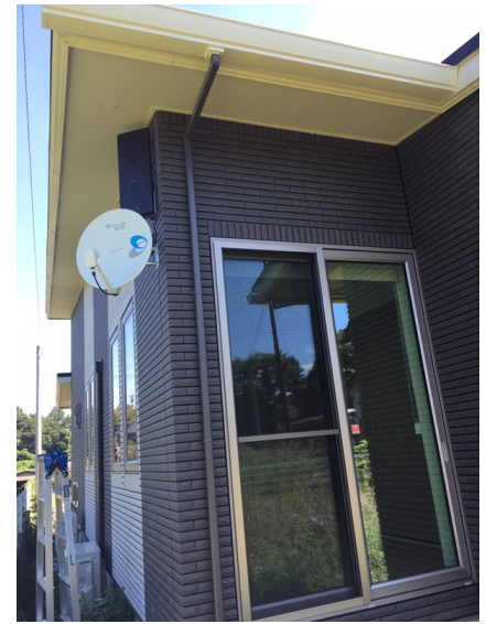
野田市山崎 一条工務店様物件 壁面取付 デザインアンテナとB Sアンテナ工事
