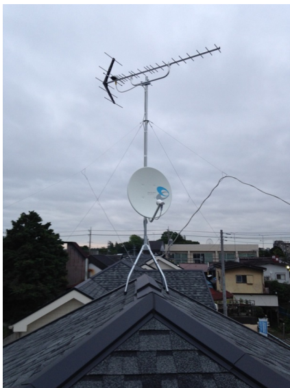
野田市野田 飯田産業様物件 地デジアンテナとBSアンテナ屋根上工事
