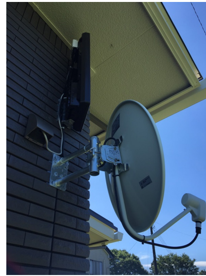
野田市山崎 一条工務店様物件 壁面取付 デザインアンテナとB Sアンテナ工事
