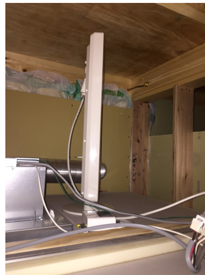
野田市清水公園東 広島建設様物件 デザインアンテナ屋根裏工事
