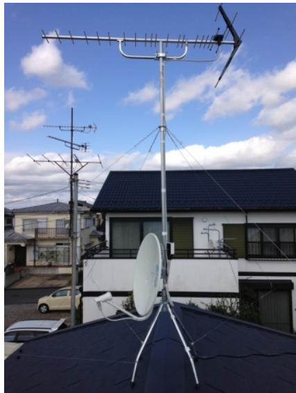
成田市吾妻 一建設様物件 地デジアンテナとBSアンテナ屋根上工事
