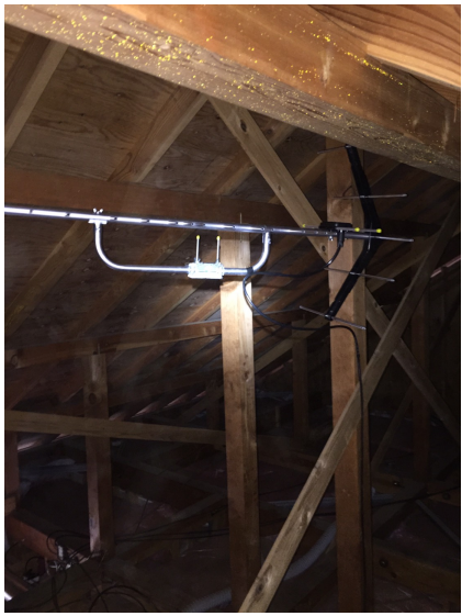
成田市並木町 屋根裏設置 地デジアンテナ工事
