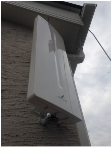
成田市並木町 佐久間工務店様物件 壁面取付 デザインアンテナ工事
