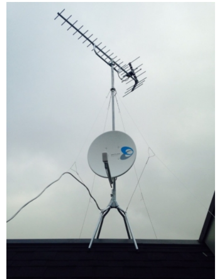
成田市団護台 クレス不動産様物件 地デジアンテナとBSアンテナ屋根上工事
