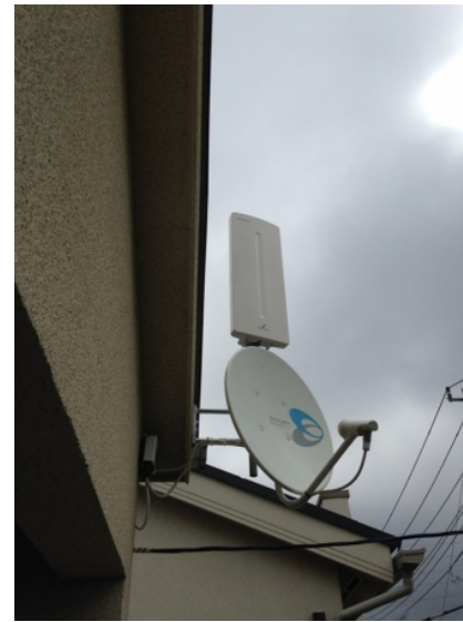
成田市はなのき台 細田工務店様物件 壁面取付 デザインアンテナとBSアンテナ工事
