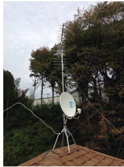
成田市不動ヶ岡 地デジアンテナとBSアンテナ屋根上工事
