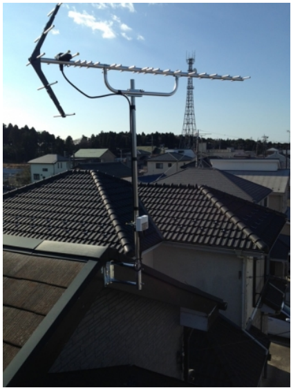
成田市並木町 藤崎建設様物件 壁面取付 地デジアンテナ工事
