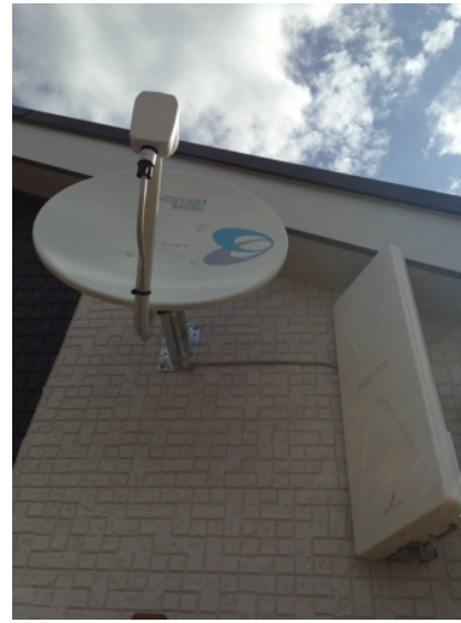
成田市本城 アーネストワン様物件 壁面取付 デザインアンテナとBSアンテナ工事
