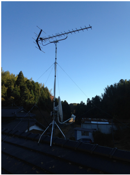
成田市下方 ワールドハウス様ご物件 屋根上設置 八木式アンテナとBS/CSアンテナ工
