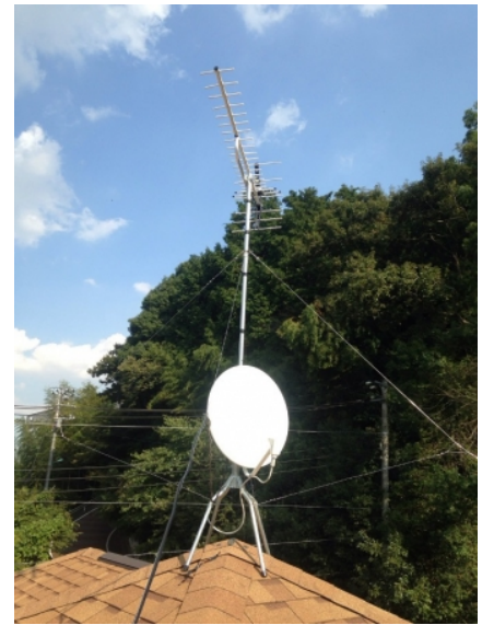
成田市不動ヶ岡 地デジアンテナとBSアンテナ屋根上工事
