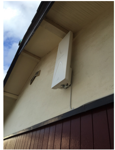
成田市並木町 壁面取付 デザインアンテナ工事
