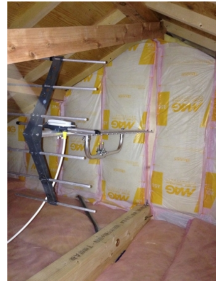
成田市不動ヶ岡 アーネストワン様物件 地デジアンテナ屋根裏工事
