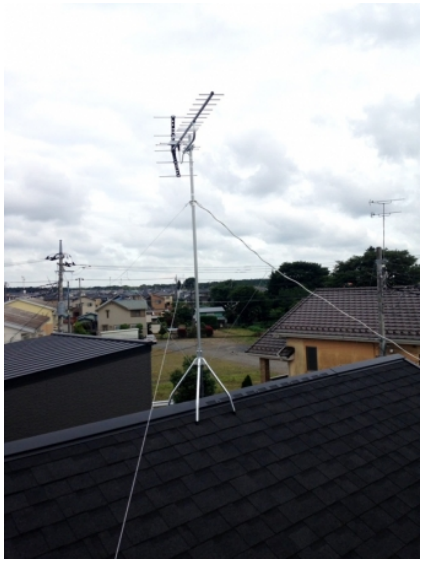
成田市西三里塚 タクトホーム様物件 地デジアンテナ屋根上工事
