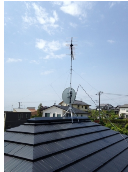
成田市中央 積水ハウス様物件 地デジアンテナとBSアンテナ屋根上工事
