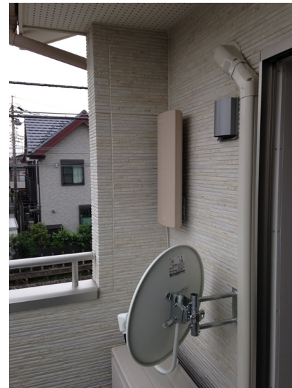
松戸市五香 壁面取付 デザインアンテナとBSアンテナ工事
