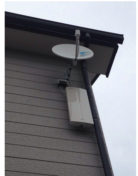
松戸市横須賀 壁面取付 デザインアンテナとBSアンテナ工事
