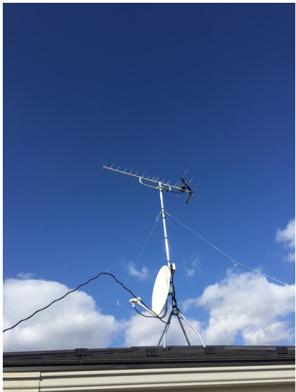
松戸市松戸新田 地デジアンテナとBSアンテナ屋根上工事
