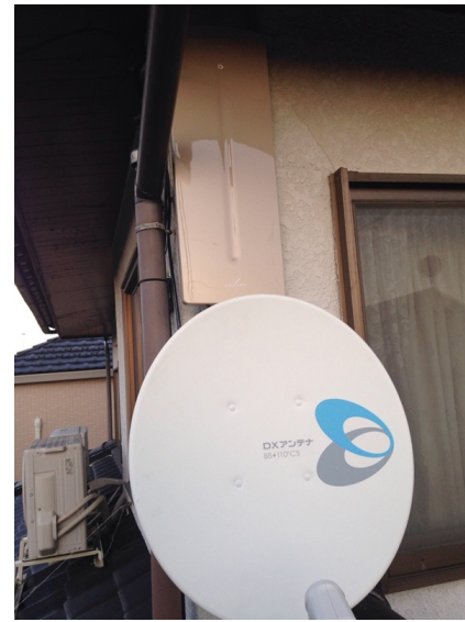
松戸市樋野口 壁面取付 デザインアンテナとBSアンテナ工事
