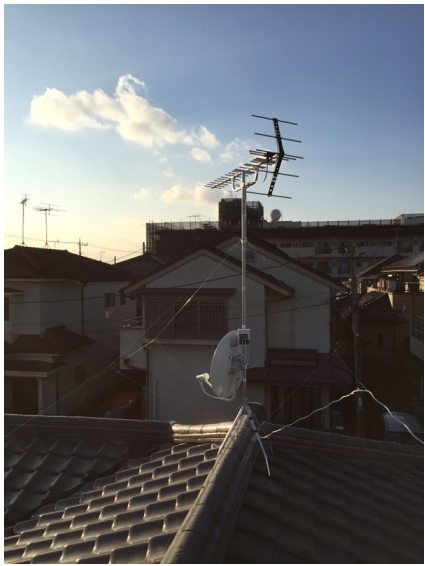
松戸市栄町 地デジアンテナとBSアンテナ屋根上工事
