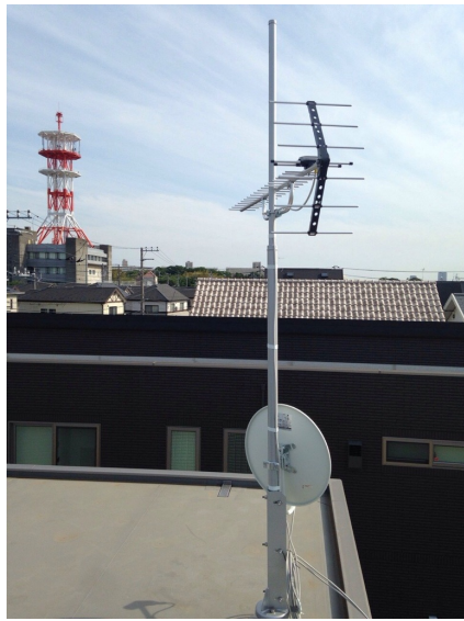
松戸市高塚新田 地デジアンテナとBSアンテナ 取付工事
