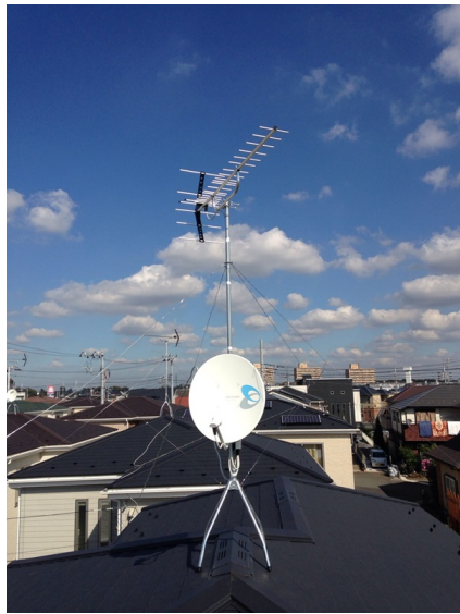
松戸市高塚新田 地デジアンテナとBSアンテナ屋根上工事
