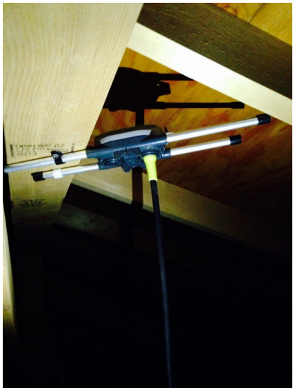
松戸市総台 地デジアンテナ屋根裏工事
