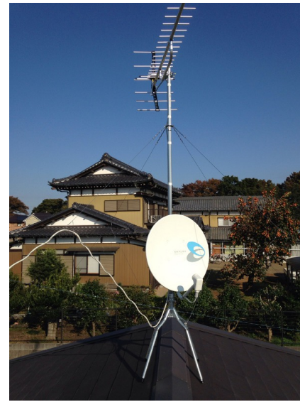
松戸市殿平賀 地デジアンテナとBSアンテナ屋根上工事
