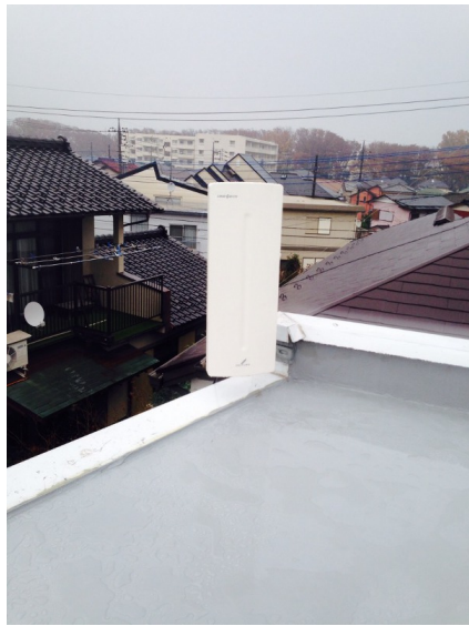
松戸市常盤平双葉町 壁面取付 デザインアンテナ工事
