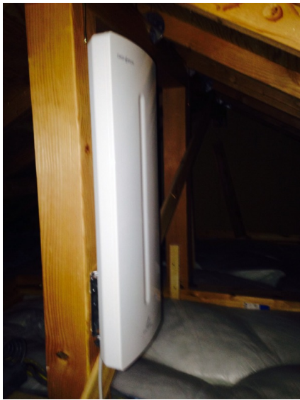
松戸市岩瀬 デザインアンテナ屋根裏工事
