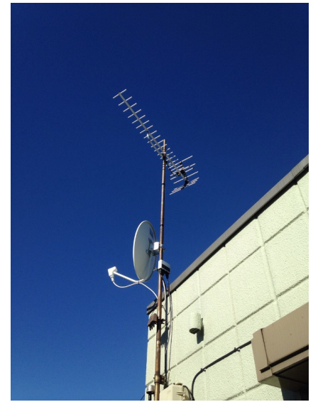
松戸市下矢切 地デジアンテナとBSアンテナ追加工事
