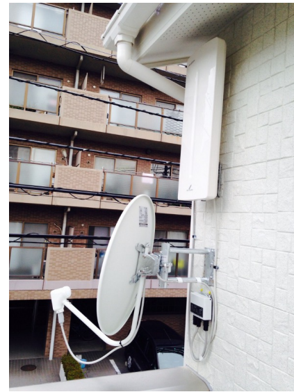
松戸市上本郷 壁面取付 デザインアンテナとBSアンテナ工事
