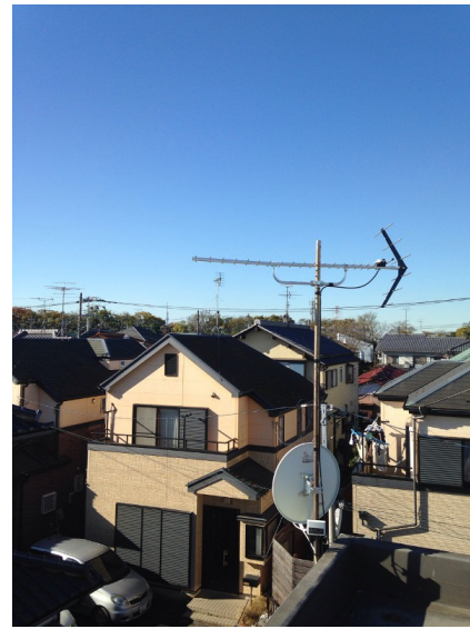
松戸市下矢切 地デジアンテナとBSアンテナ追加工事
