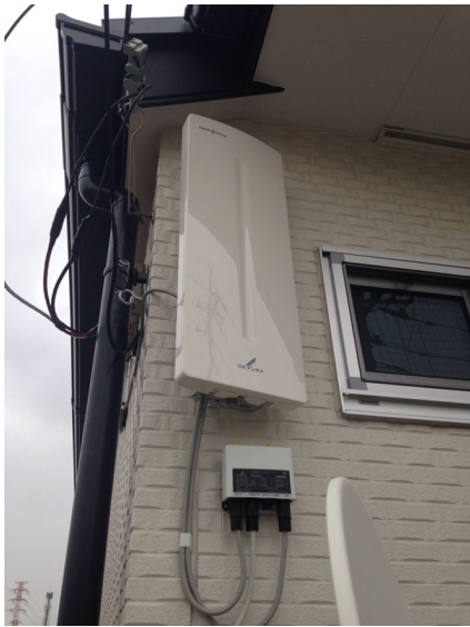
松戸市秋山 壁面取付 デザインアンテナ工事
