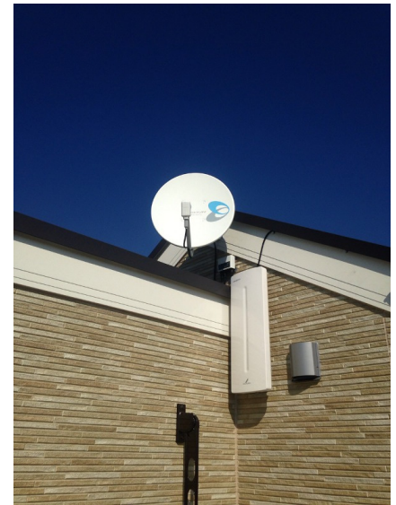
松戸市五香 壁面取付 デザインアンテナとBSアンテナ工事
