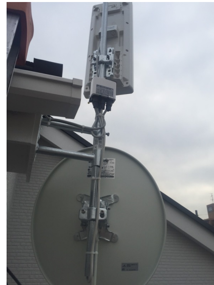
松戸市金ヶ作 タクトホーム様物件 壁面取付 デザインアンテナとBSアンテナ工事
