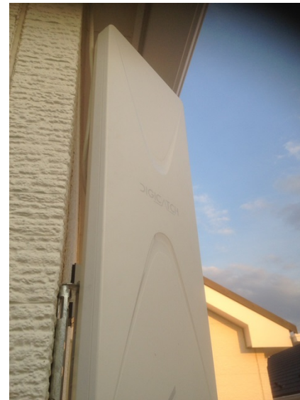
松戸市新松戸 ポラス様物件 壁面取付 デザインアンテナ工事
