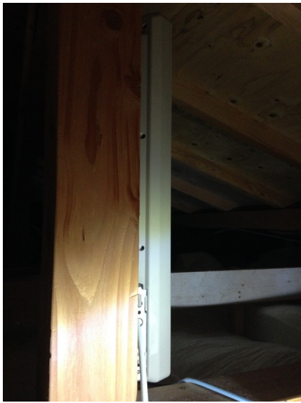
松戸市新松戸 ポラス様物件 デザインアンテナ屋根裏工事
