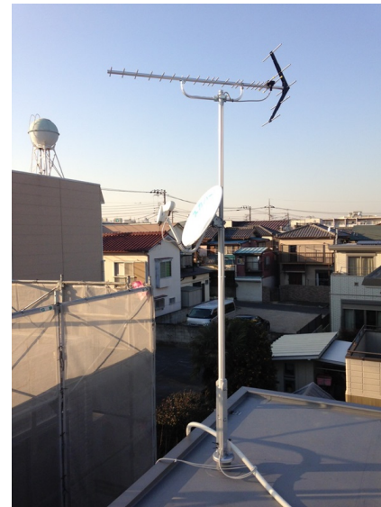
松戸市総台 旭化成様物件 地デジアンテナと持ち込みCSアンテナ工事
