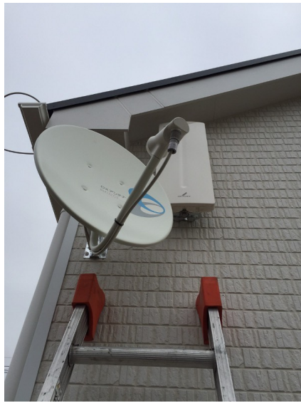
松戸市金ケ作 アーネストワン様物件 壁面取付 デザインアンテナとBSアンテナ工事
