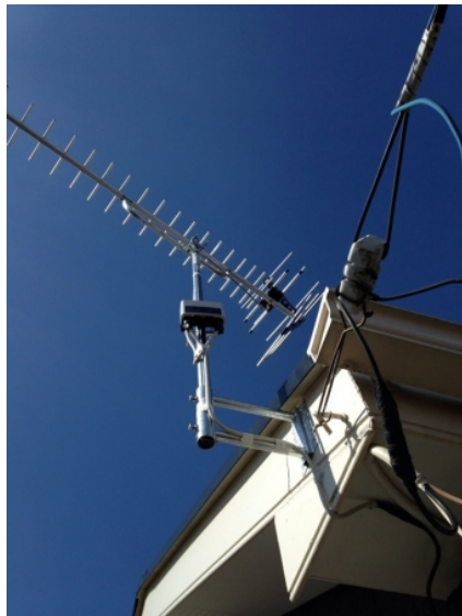
上尾市小泉 壁面取付 地デジアンテナ工事
