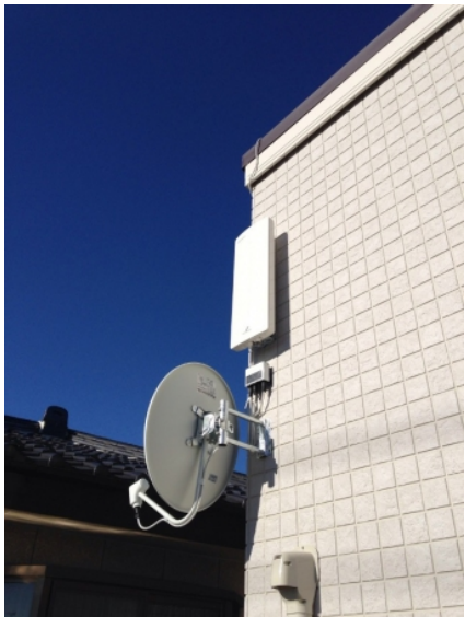
上尾市平方 壁面取付 デザインアンテナとBSアンテナ工事
