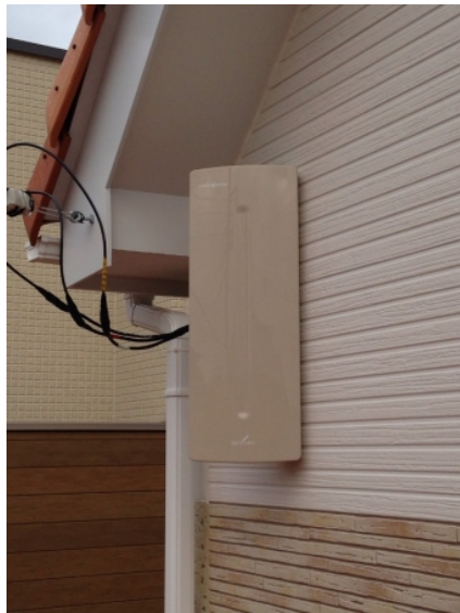
上尾市富士見 壁面取付 デザインアンテナ工事
