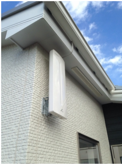
上尾市小泉 壁面取付 デザインアンテナ工事
