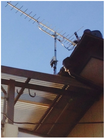
上尾市上野本郷 壁面取付 地デジアンテナ工事
