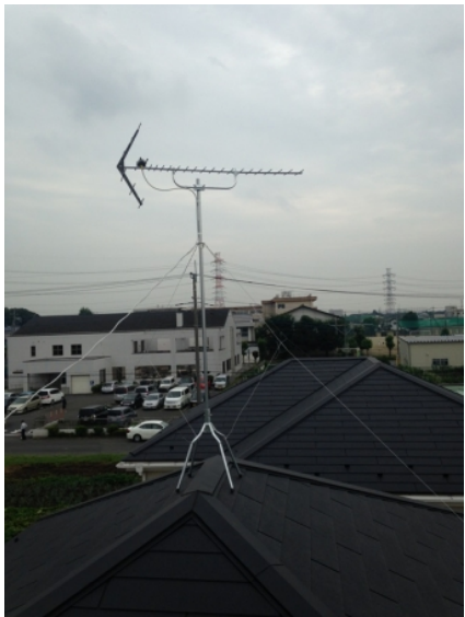
上尾市緑丘 地デジアンテナ屋根上工事
