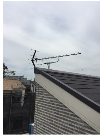
上尾市瓦葺 城南建設様物件 壁面取付 地デジアンテナ工事
