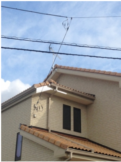
上尾市地頭方 大塚建設様物件 壁面取付 地デジアンテナ工事
