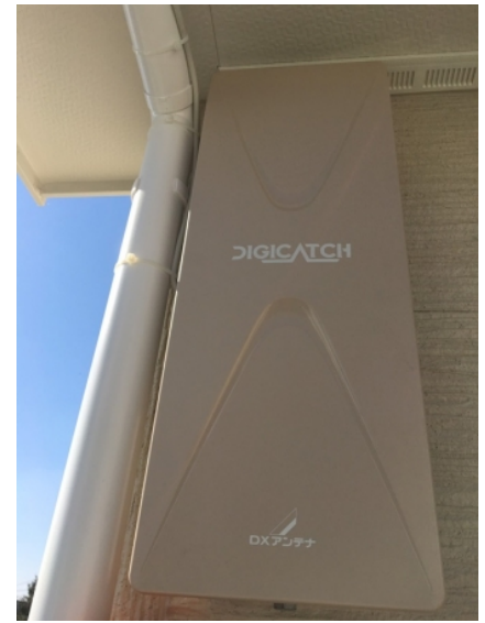
上尾市瓦葺 一建設様物件 壁面取付 デザインアンテナ工事
