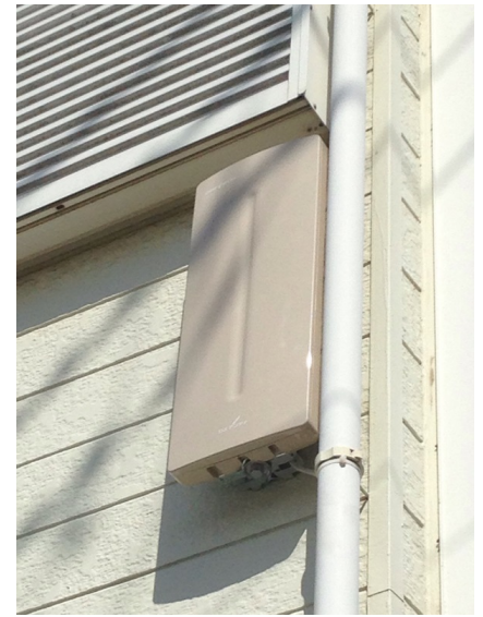
船橋市金杉 壁面取付 デザインアンテナ工事
