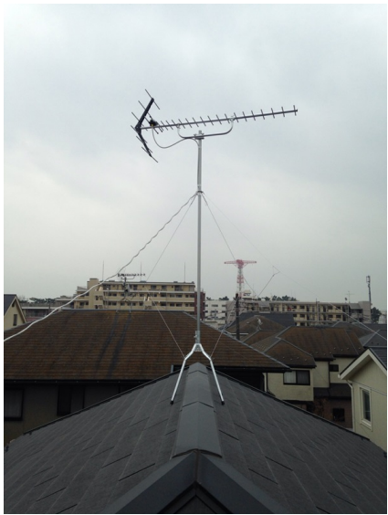
船橋市習志野台 地デジアンテナ屋根上工事
