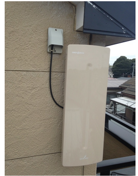
船橋市藤原 壁面取付 デザインアンテナ工事
