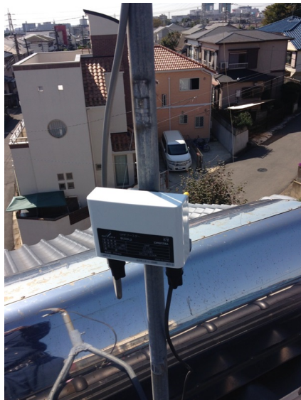
船橋市田喜野井 ブースター交換工事
