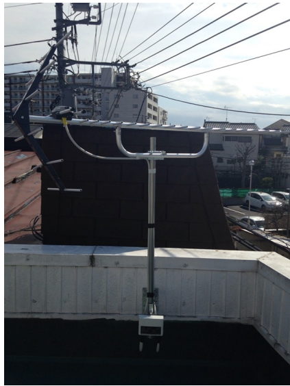
船橋市藤原 壁面取付 地デジアンテナ工事
