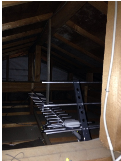
船橋市新高根 地デジアンテナ屋根裏工事
