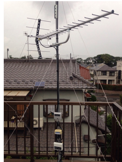
船橋市古作 地デジアンテナ追加工事
