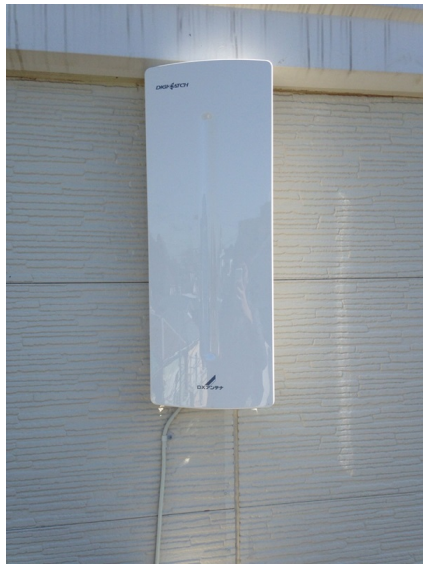
船橋市藤原 壁面取付 デザインアンテナ工事
