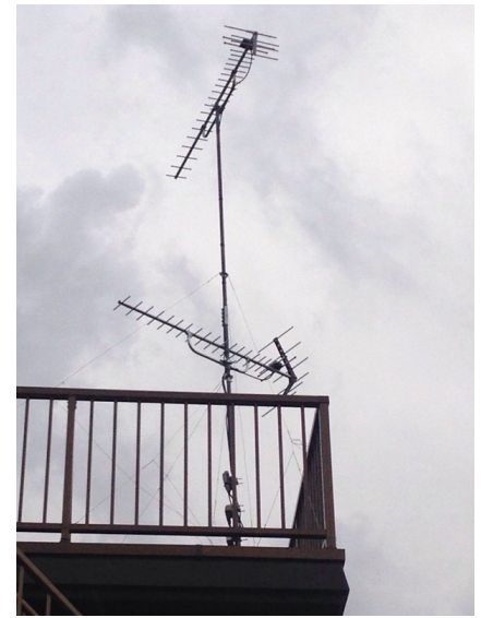
船橋市二宮 地デジアンテナとBSアンテナ工事
