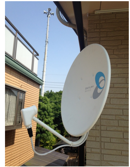
船橋市前貝塚町 壁面取付 BSアンテナ工事
