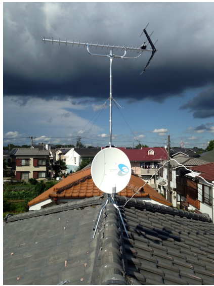
船橋市行田 地デジアンテナとBSアンテナ屋根上工事
