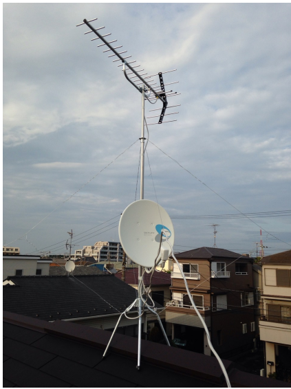
船橋市前原東 地デジアンテナとBSアンテナ屋根上工事
