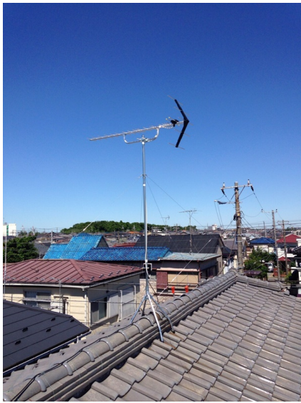
船橋市大穴北 日東エネルギー様物件 地デジアンテナ屋根上工事
