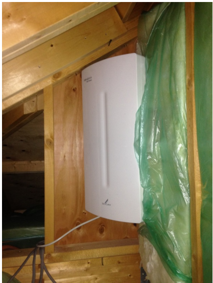
船橋市夏見 三井不動産レジデンシャル デザインアンテナ屋根裏工事
