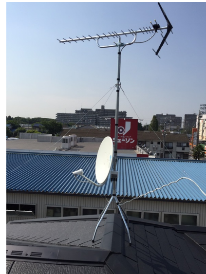
船橋市東中山 マイホームテクノ様物件 壁面取付 デザインアンテナとBSアンテナ工事
