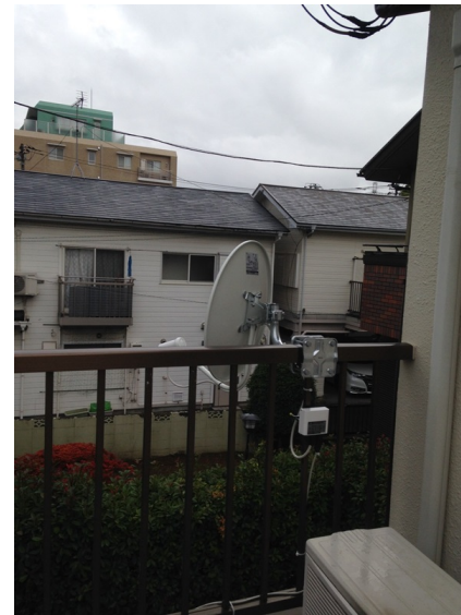
船橋市夏見 教峯建設様物件 ベランダ取付 B S アンテナ工事
