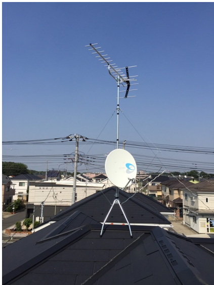
船橋市藤原 一建設様物件 地デジアンテナとBSアンテナ屋根上工事
