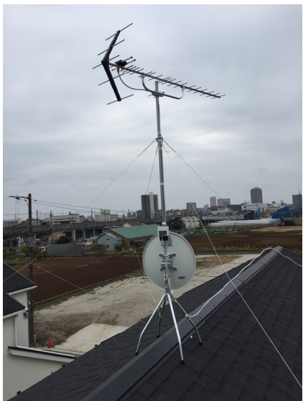
船橋市夏見 アーネストワン様物件 地デジアンテナとB S アンテナ屋根上工事
