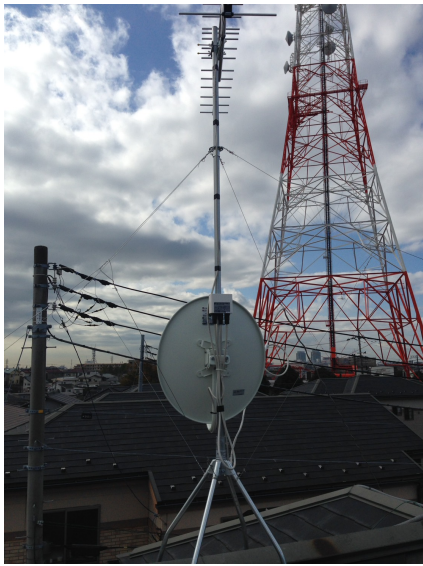
船橋市三山 東栄住宅様物件 地デジアンテナとBSアンテナ屋根上工事
