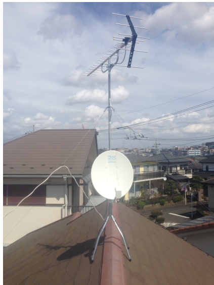
船橋市西習志野 屋根上設置 八木式アンテナとBS/CSアンテナ工事
