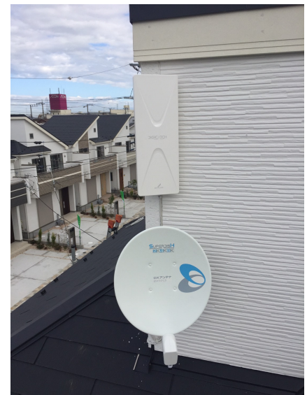
船橋市西習志野 東栄住宅様物件 壁面取付 デザインアンテナとBSアンテナ工事
