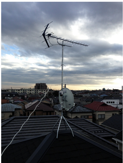
船橋市二宮 地デジアンテナとBSアンテナ屋根上工事
