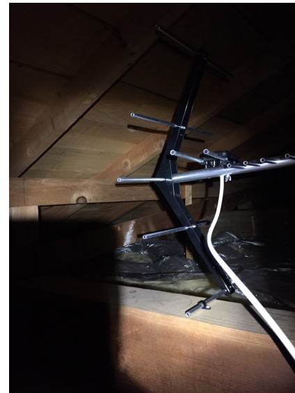
船橋市旭町 東海住宅様ご物件 屋根裏設置 八木式アンテナ工事
