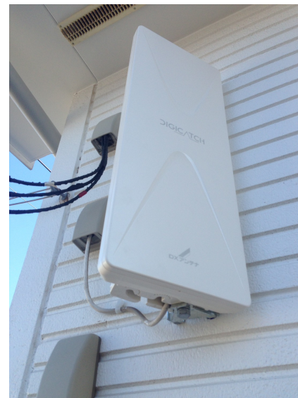
船橋市丸山 壁面取付 デザインアンテナ工事
