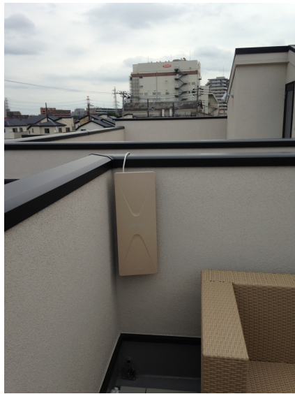
船橋市山手 アーバンクロスデザイン様物件 壁面取付 デザインアンテナ工事
