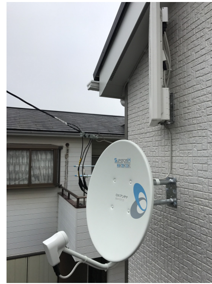
船橋市芝山 秀栄様物件 壁面取付 デザインアンテナとBSアンテナ工事
