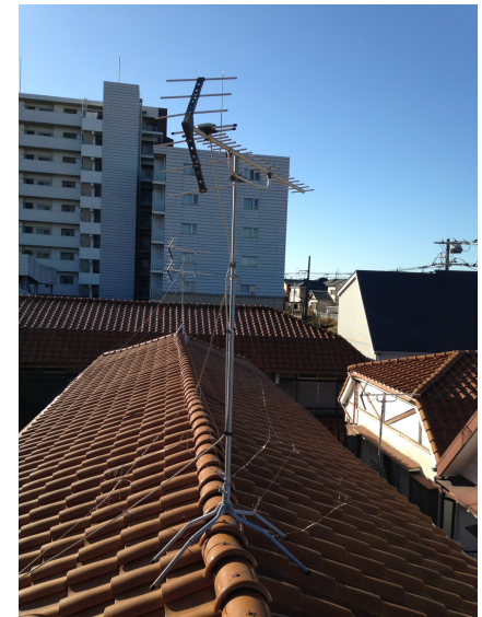
船橋市藤原 ミタホーム様ご物件 屋根上設置 八木式アンテナ工事
