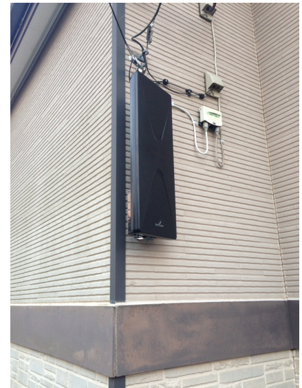
船橋市桶が山町 壁面取付 デザインアンテナ工事
