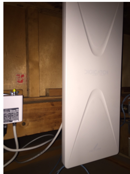
船橋市習志野台 屋根裏設置 デザインアンテナ工事
