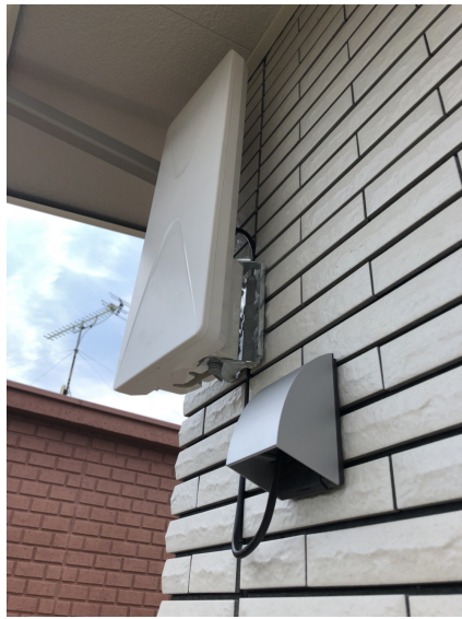
流山市江戸川台東 一条工務店様ご物件 壁面取付 デザインアンテナ工事
