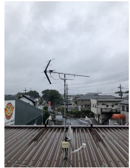
流山市駒木 八木式アンテナ交換工事
