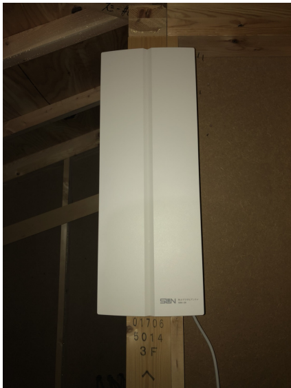
流山市西平井 アキュラホーム様ご物件 屋根裏取付 デザインアンテナ工事
