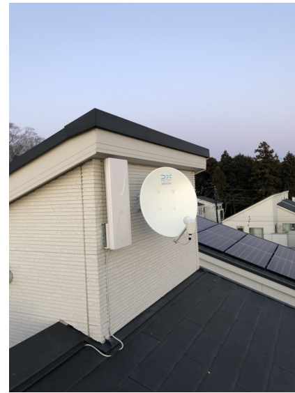
流山市三輪野山 タカラレーベン様ご物件 壁面取付 デザインアンテナ・BSCSアンテナ工事
