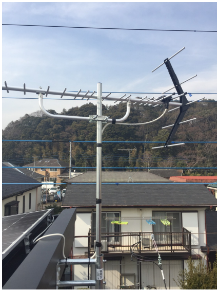
流山市宮園 一条工務店様ご物件 破風板取付 八木式アンテナ工事
