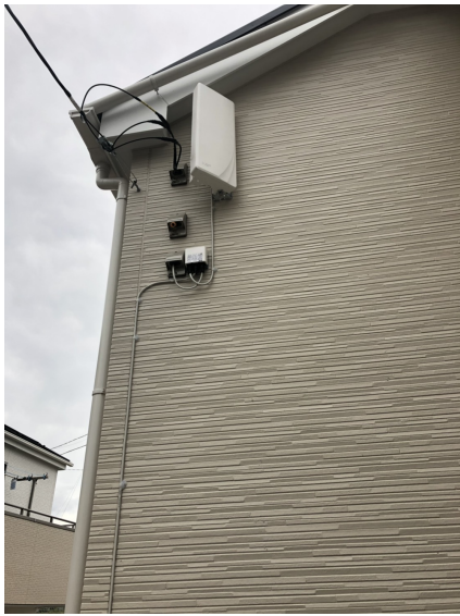
流山市西深井 壁面取付 デザインアンテナ工事
