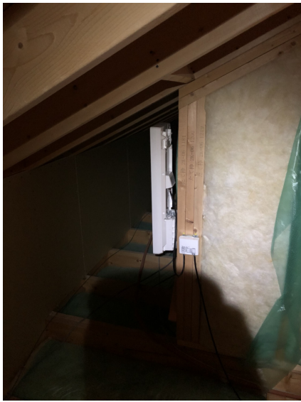
流山市市野谷 三井不動産様ご物件 屋根裏取付 デザインアンテナ工事
