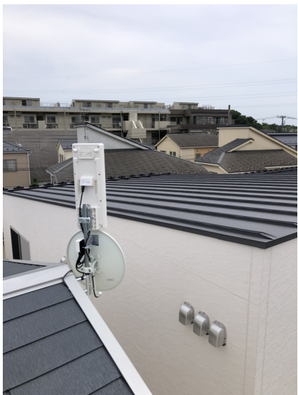
流山市向小金 デザインアンテナとBSCSアンテナの破風板取り付け
