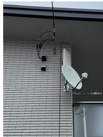
流山市東深井 デザインアンテナとBSCSアンテナの壁面取り付け
