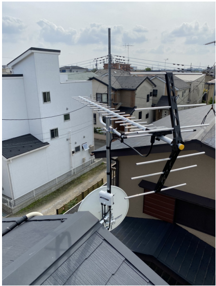
流山市南流山 住友不動産様ご物件 破風板取付 八木式アンテナとBSCSアンテナT
