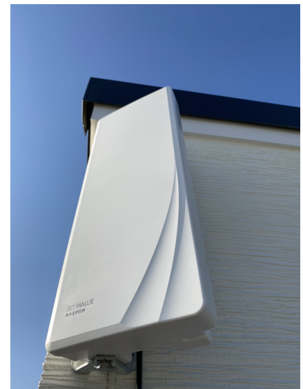
流山市古間木 デザインアンテナの壁面取り付け
