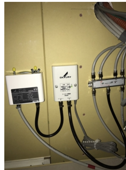
浦安市富士見 三栄建築設計様物件 ブースター電源部 ブースター本体 6分配器
