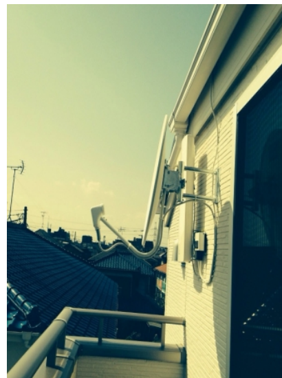
浦安市海楽 壁面取付 デザインアンテナとBSアンテナ工事
