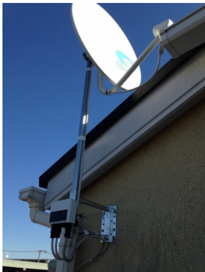
浦安市東野 壁面取付 BSアンテナ工事
