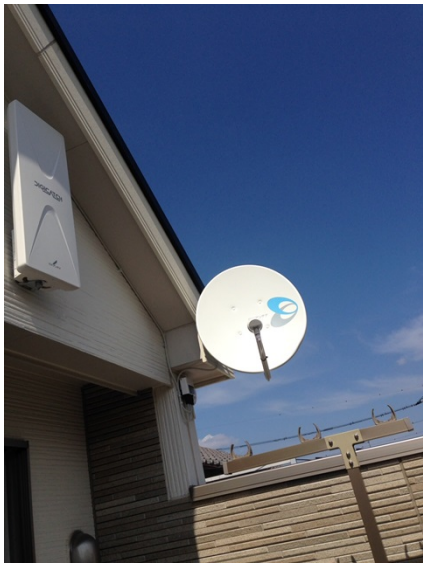
佐倉市栄町 一建設様物件 壁面取付 デザインアンテナとBSアンテナ工事
