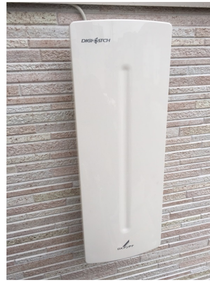
佐倉市染井野 ミサワホーム様物件 壁面取付 デザインアンテナ工事
