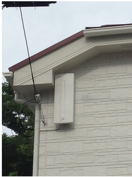
佐倉市寺崎北 広島建設様物件 デザインアンテナ工事
