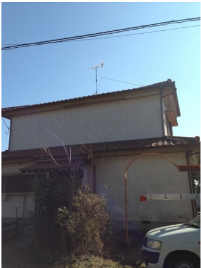
大網白里市木崎 エフピーランナー様物件 地デジアンテナ工事後の外観
