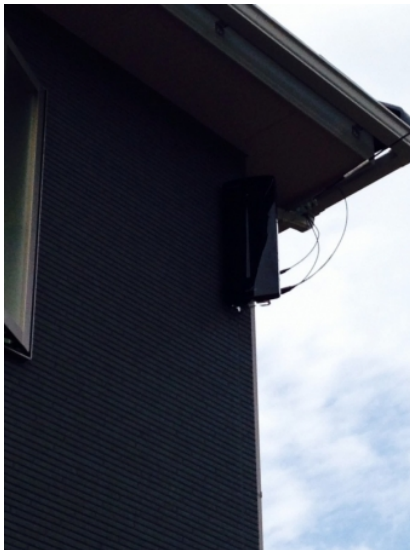
大網白里市柿餅 壁面取付 デザインアンテナ工事
