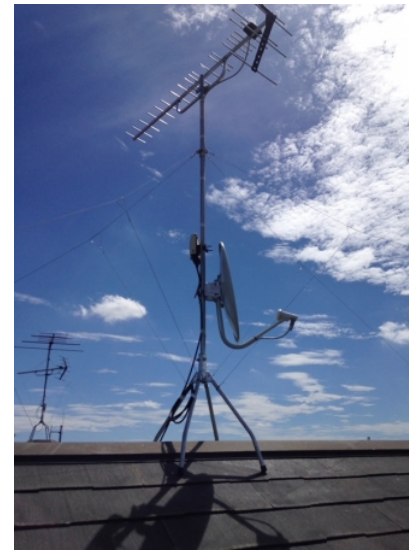
大網白里市みやこ野 地デジアンテナとBSアンテナ屋根上工事
