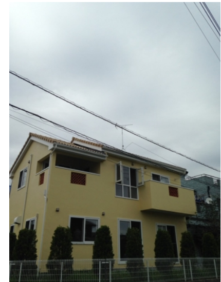
大網白里市みどりヶ丘 地デジアンテナ工事後の外観
