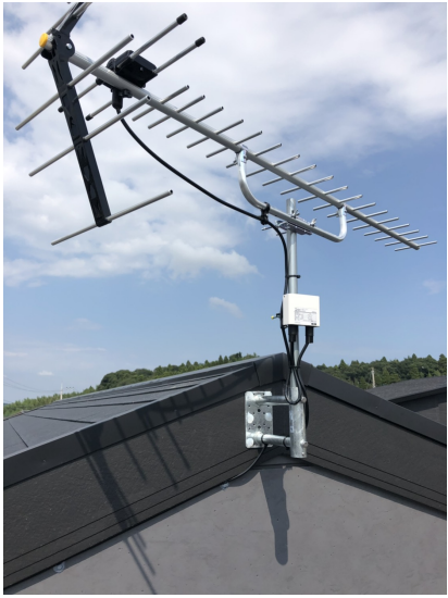
大網白里市 破風板取付 八木式アンテナ工事
