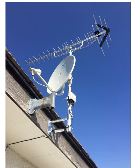
大網白里市北今泉 破風板取付 八木式アンテナとBS/CSアンテナ工 事
