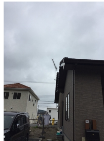
大網白里市みどりヶ丘 ワールドハウス様物件 地デジアンテナ工事後の外観
