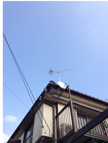
柏市常盤台 地デジアンテナとBSアンテナ工事
