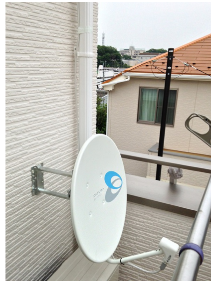
柏市豊住 壁面取付 BSアンテナ工事
