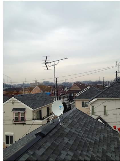
柏市篠籠田 ボラス様物件 地デジアンテナとB Sアンテナ屋根上工事
