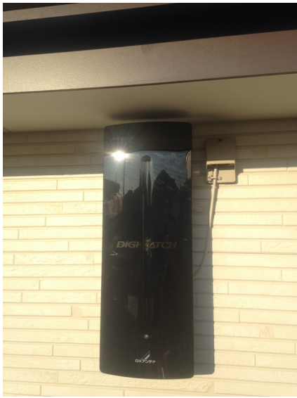
柏市東中新宿 アイダ設計様物件 壁面取付 デザインアンテナ工事
