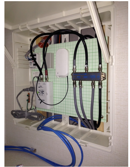
柏市篠籠田 ボラス様物件 ブースター電源部 6分配器
