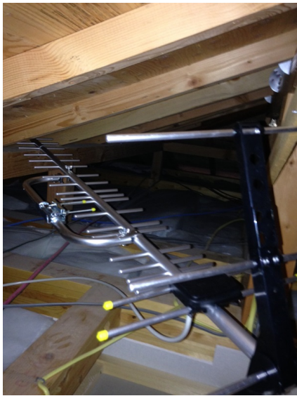
柏市東柏 ボラス様物件 地デジアンテナ屋根裏工事
