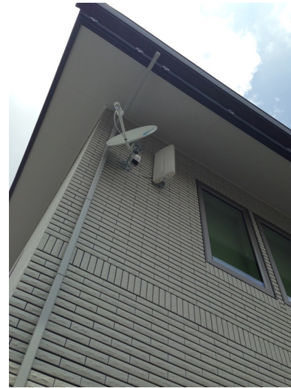
柏市高田 一条工務店様物件 壁面取付 デザインアンテナとBSアンテナ工事
