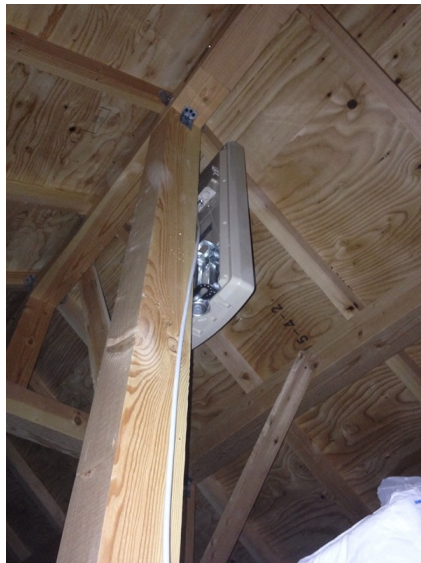
柏市今谷南町 ボラス住宅様物件 デザインアンテナ屋根裏工事
