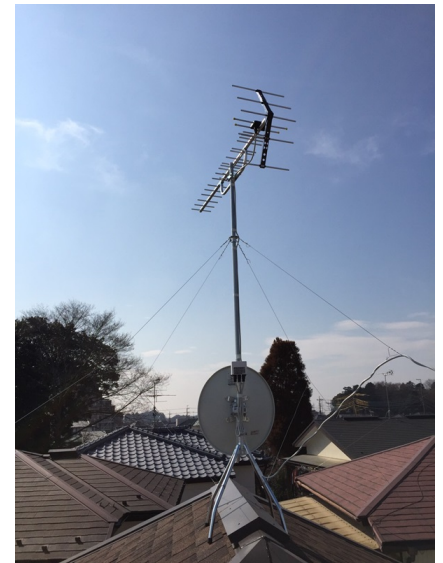
柏市豊四季 ボラス様物件 地デジアンテナとBSアンテナ屋根上工事
