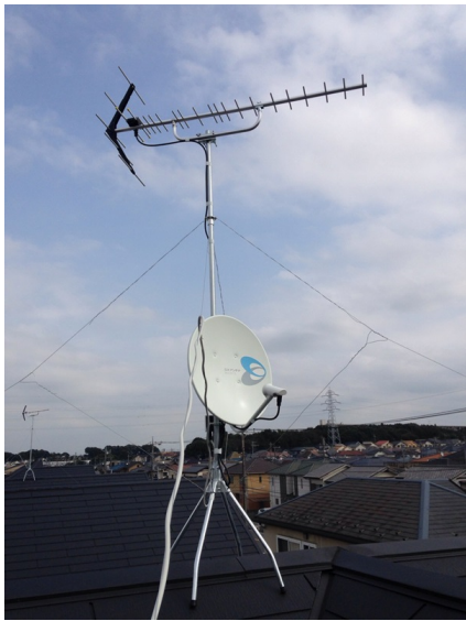
柏市酒井根 地デジアンテナとBSアンテナ屋根上工事
