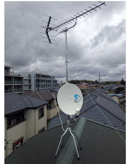
柏市ひばりが丘 三井不動産様物件 地デジアンテナとBSアンテナ屋根上工事
