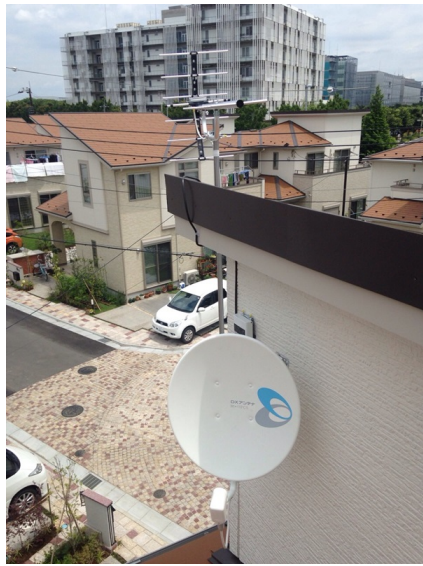
柏市柏の葉 ポラス様物件 壁面取付 地デジアンテナとBSアンテナ工事
