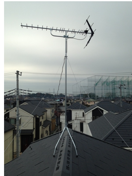
柏市篠籠田 タクトホーム様物件 地デジアンテナ屋根上工事
