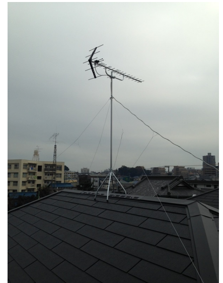
柏市篠籠田 タクトホーム様物件 地デジアンテナ屋根上工事
