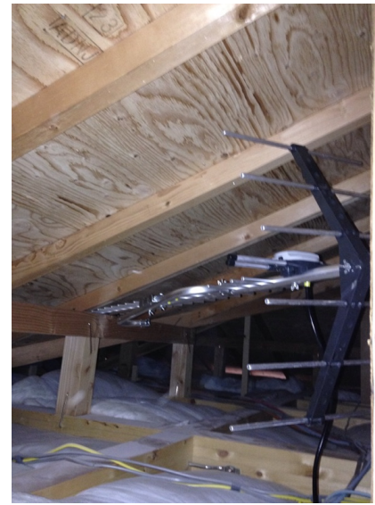
柏市柏の葉 ボラス住宅様物件 地デジアンテナ屋根裏工事
