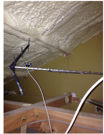
柏市高柳 タカラレーベン様物件 地デジアンテナ屋根裏工事
