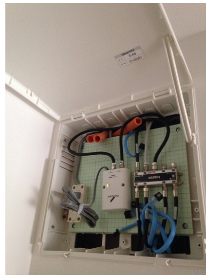
柏市船戸 ボラス様物件 ブースター電源部 8分配器
