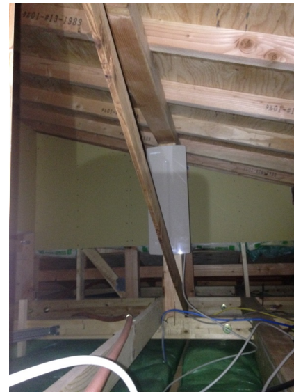
柏市高柳 アキュラホーム様物件 デザインアンテナ屋根裏工事
