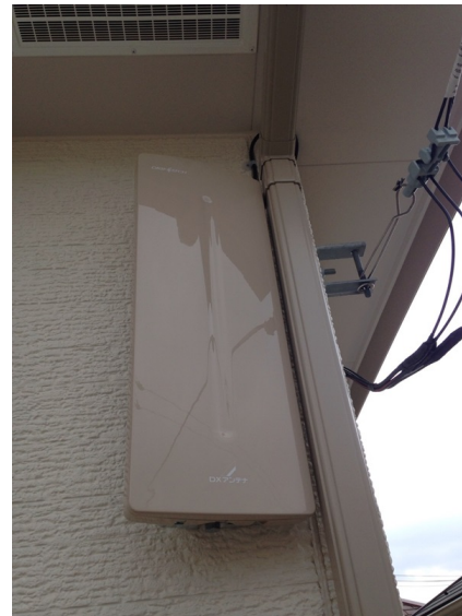
柏市今谷上町 ボラス様物件 壁面取付 デザインアンテナ工事
