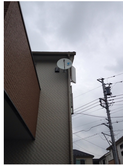
柏市富里 広島建設様物件 壁面取付 デザインアンテナとBSアンテナ工事
