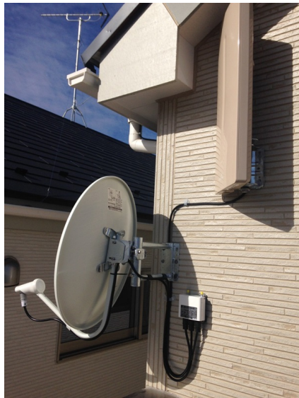
柏市酒井根 壁面取付 デザインアンテナとBSアンテナ工事
