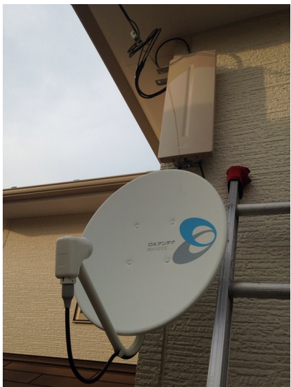
柏市船戸 ボラス様物件 壁面取付 デザインアンテナとBSアンテナ工事
