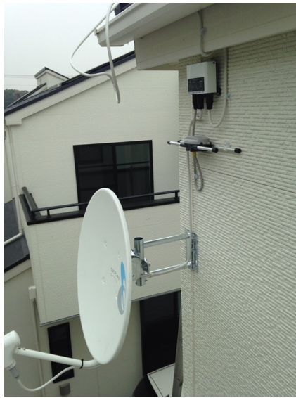
柏市高柳 タカラレーベン様物件 壁面取付 BSアンテナ工事
