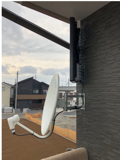
柏市高柳 デザインアンテナとBS/CSアンテナの壁面取り付け
