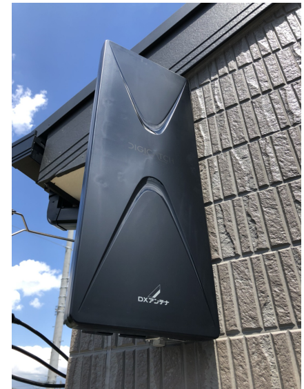
柏市西山 デザインアンテナの壁面取り付け
