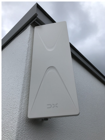
柏市豊四季 デザインアンテナの壁面取り付け
