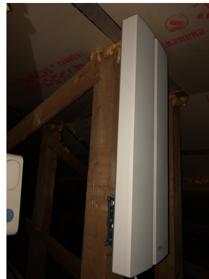
柏市大津ヶ丘 デザインアンテナの屋根裏設置
