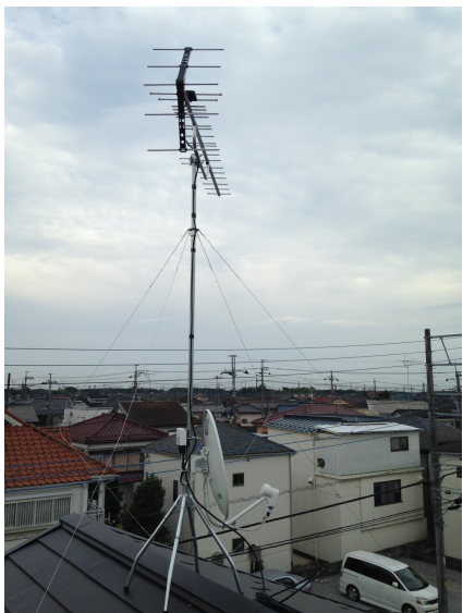
柏市逆井 八木式アンテナとBSCSアンテナの屋根上設置
