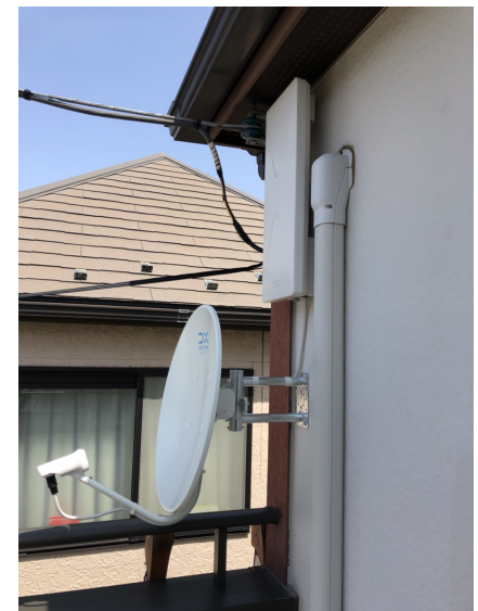
柏市藤心 デザインアンテナとBS/CSアンテナの壁面取り付け
