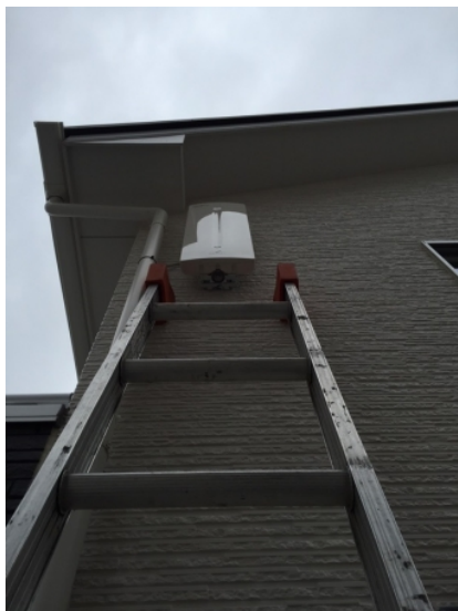
印西市西の原 壁面取付 デザインアンテナ工事
