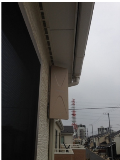
印西市原山 壁面取付 デザインアンテナ工事
