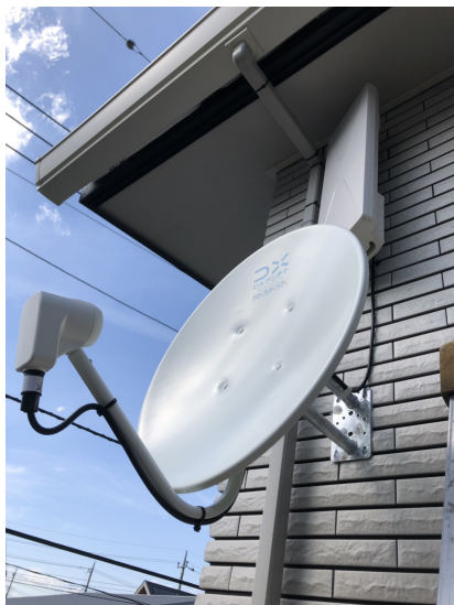
印西市小林大門下 一条工務店様ご物件 デザインアンテナとBS/CSアンテナの壁面設置
