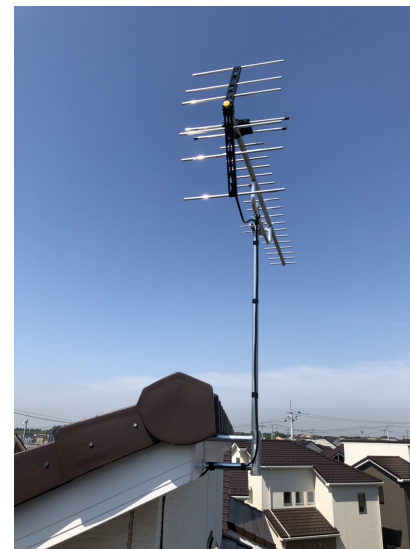
印西市東の原 八木式アンテナの破風板設置
