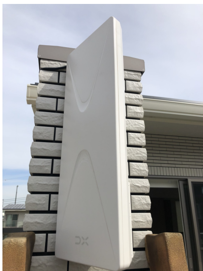
印西市牧の原 一条工務店様ご物件 デザインアンテナの壁面設置
