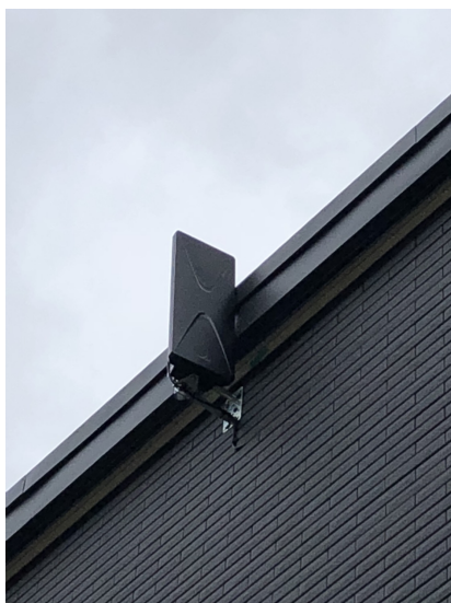
印西市笠神 一条工務店様ご物件 壁面設置 デザインアンテナ工事
