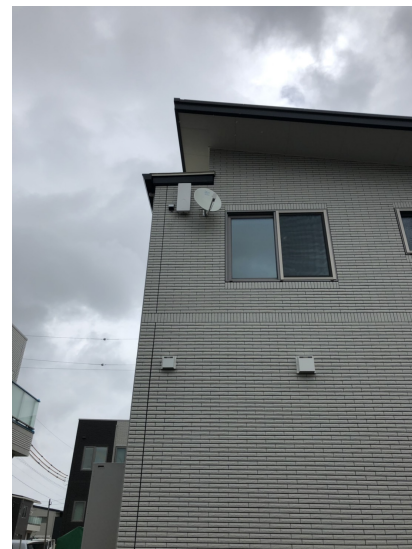
印西市牧の原 一条工務店様ご物件 デザインアンテナの壁面取り付け
