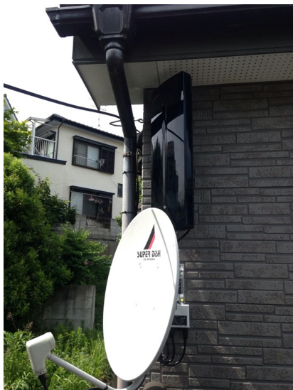
市川市宮久保 壁面取付 デザインアンテナとBSアンテナ工事
