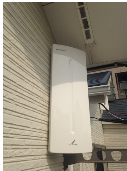
市川市相之川 壁面取付 デザインアンテナ工事
