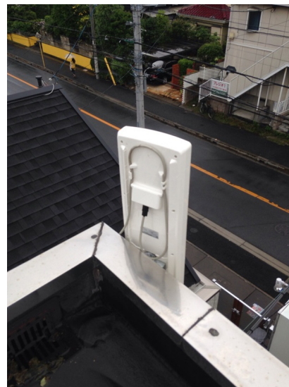
市川市塩焼 壁面取付 デザインアンテナ工事
