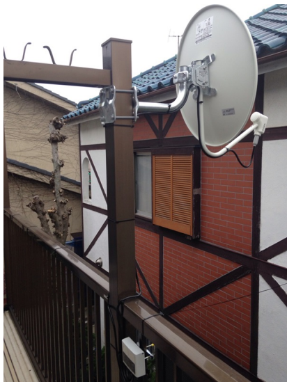
市川市富浜 ベランダ取付 BSアンテナ工事
