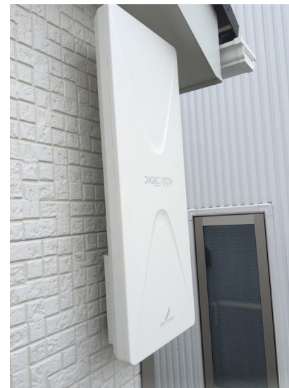
市川市大野町 アーネストワン様物件 壁面取付 デザインアンテナ工事
