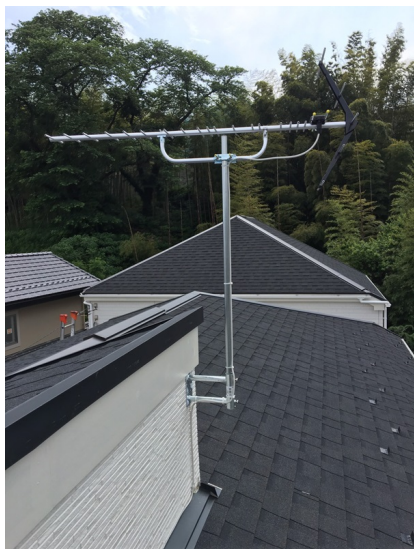
市川市真間 飯田産業様物件 壁面取付 地デジアンテナ工事
