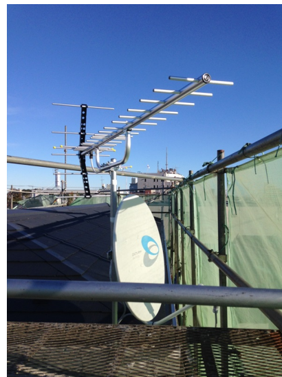
市川市八幡 住友林業様物件 壁面取付 地デジアンテナとBSアンテナ工事
