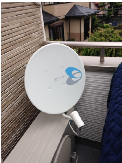
市川市宮久保 東栄住宅様物件 壁面取付 BSアンテナ工事
