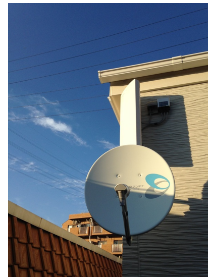
市川市日之出 サンウエスト様物件 壁面取付 デザインアンテナとBSアンテナ工事
