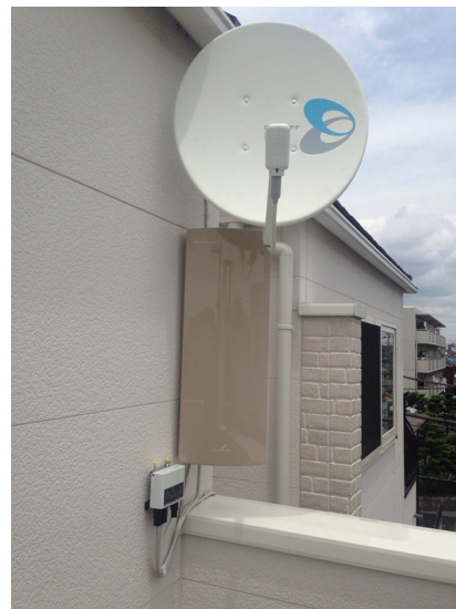
市川市柏井町 三栄建設設計様物件 壁面取付 デザインアンテナとBSアンテナ工事
