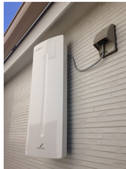
市川市宮久保 東栄住宅様物件 壁面取付 デザインアンテナ工事
