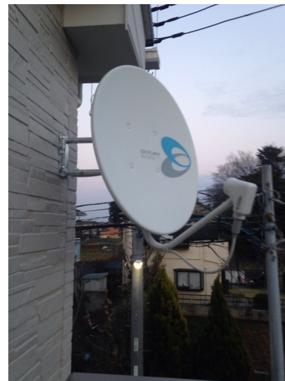
市川市鬼越 東栄住宅様物件 壁面取付 BSアンテナ工事
