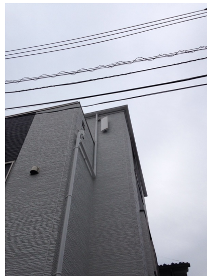
市川市妙典 三栄ホーム様物件 壁面取付 デザインアンテナ工事
