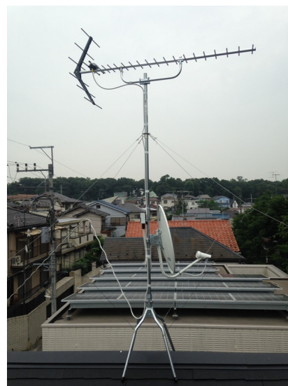
市川市国分台 広島建設様物件 地デジアンテナとBSアンテナ屋根上工事
