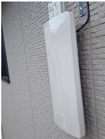
市川市大野町 ダイワハウス様物件 壁面取付 デザインアンテナ工事
