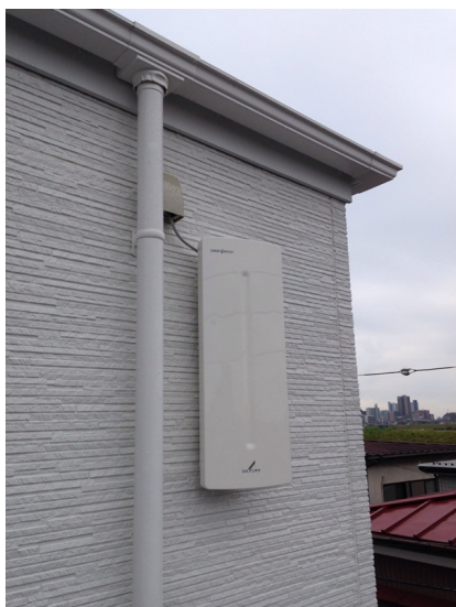
市川市大洲 セントリビング様物件 壁面取付 デザインアンテナ工事
