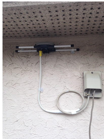
市川市国分 国分土地建物様物件 壁面取付 地デジアンテナ工事
