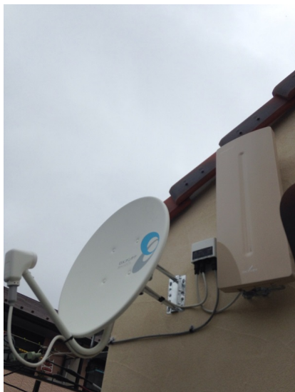
市川市妙典 DAISHU様物件 壁面取付 デザインアンテナとBSアンテナ工事
