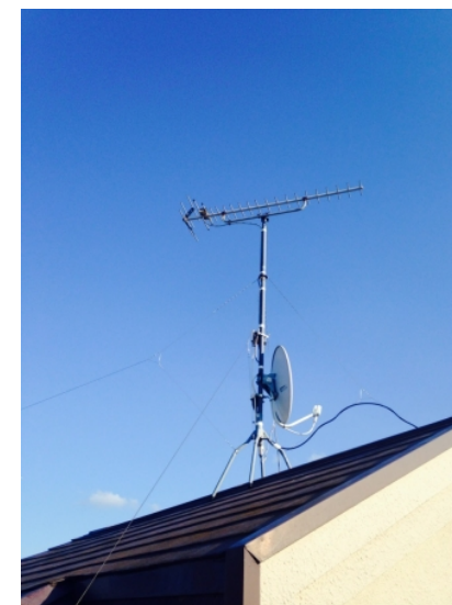
鎌ヶ谷市南初富 地デジアンテナとBSアンテナ屋根上工事
