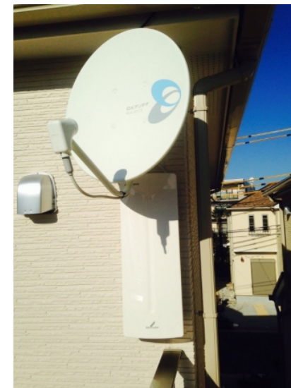
鎌ヶ谷市東中沢 壁面取付 デザインアンテナとBSアンテナ工事
