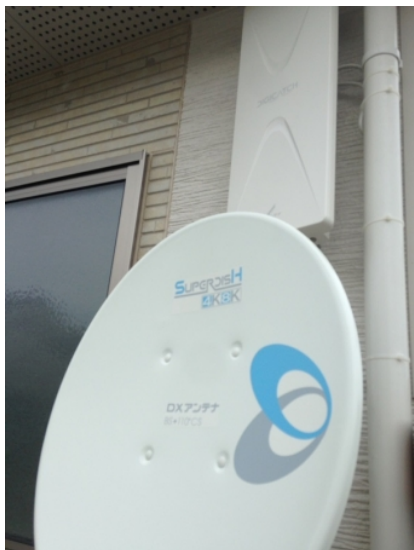
鎌ヶ谷市鎌ヶ谷 東海住宅様物件 壁面取付 デザインアンテナとBSアンテナ工事
