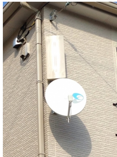
鎌ヶ谷市東中沢 ボラス住宅様物件 壁面取付 デザインアンテナとBSアンテナ工事
