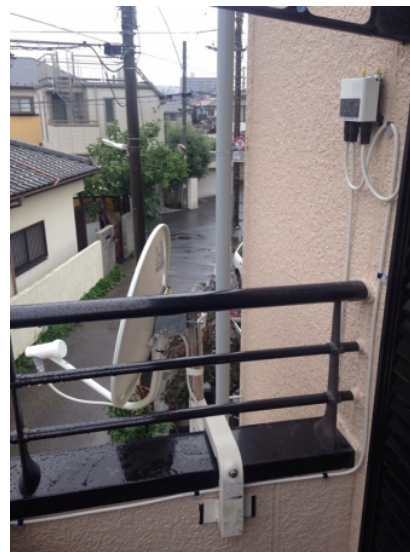
我孫子市寿 BSアンテナ挟み込み工事
