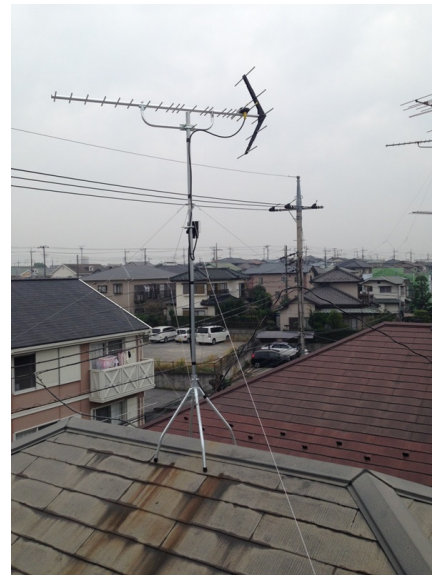
市原市更級 四季工房様物件 ポール取付 地デジアンテナ工事
