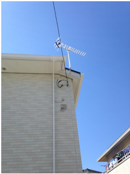
市原市ちはら台西 ダイワハウス様物件 壁面取付 地デジアンテナ工事
