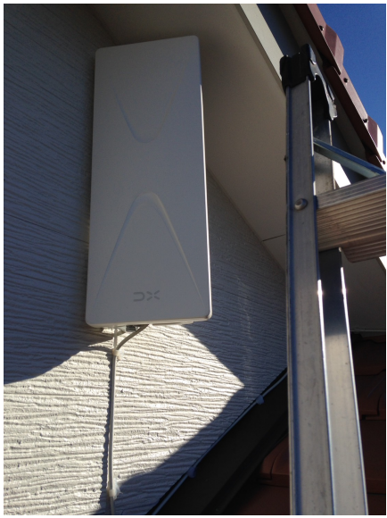
市原市若宮 アイダ設計様ご物件 壁面取付 デザインアンテナ工事
