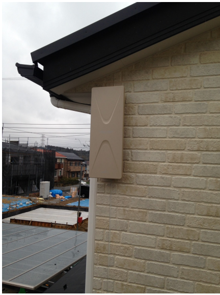
市原市ちはら台東 広島建設様ご物件 壁面取付 デザインアンテナ工事
