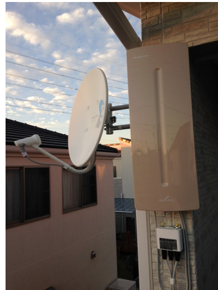
市原市ういど南 ナミカワ不動産様物件 壁面取付 デザインアンテナとBS/CSアンテナ工
