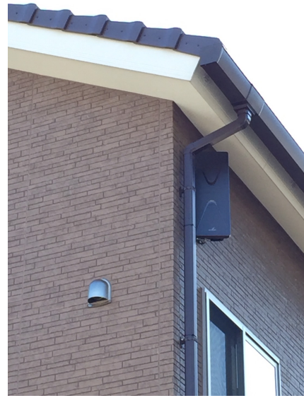
市原市ちはら台東 壁面取付 デザインアンテナ工事
