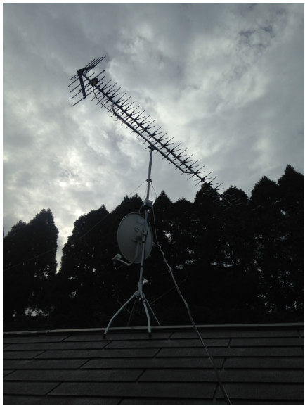
市原市瀬又 地デジアンテナとBS/CSアンテナ屋根上工事
