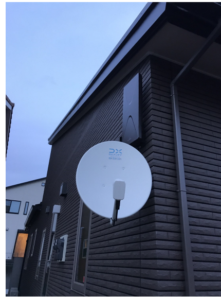
市原市ちはら台西 壁面取付 デザインアンテナとBS/CSアンテナ工事
