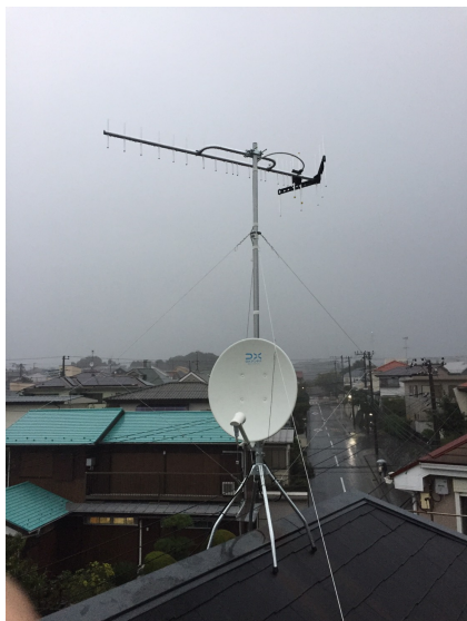
逗子市池子 地デジアンテナとBSアンテナ屋根上工事
