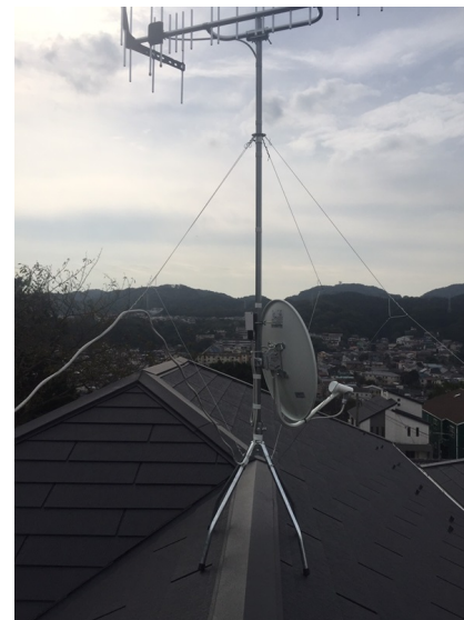
逗子市沼間 一建設様物件 垂直偏波受信 地デジアンテナとBS/CSアンテナ屋根上工事
