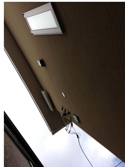
逗子市桜山 ハウスゼロ様物件 垂直偏波受信 壁面取付 デザインアンテナ工事
