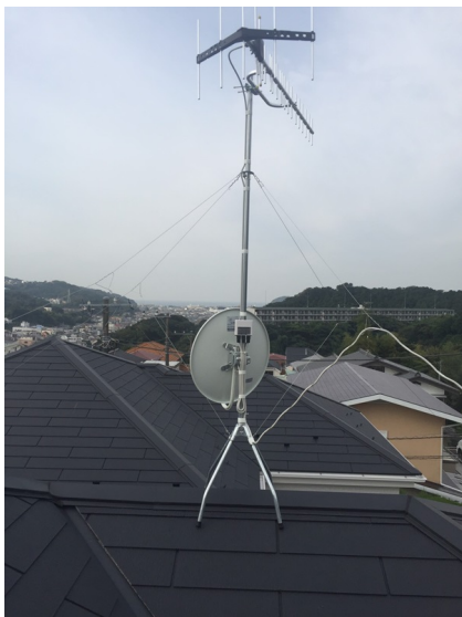
逗子市桜山 ミサワホーム様物件 八木式アンテナとBS/CSアンテナ屋根上工事
