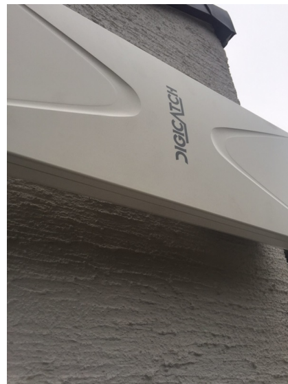
逗子市桜山 タツミプランニング様物件 壁面取付 デザインアンテナ工事
