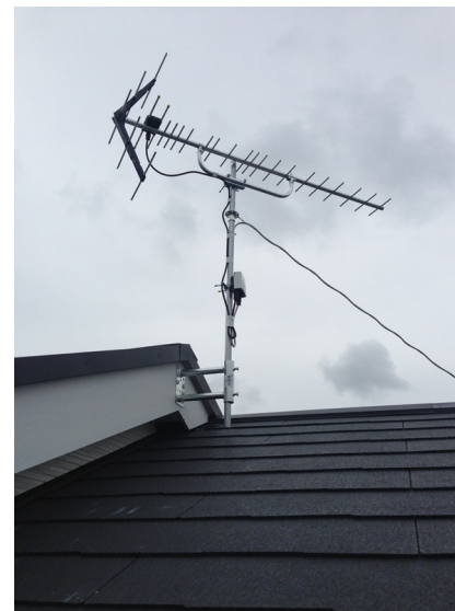
逗子市池子 破風板取付 地デジアンテナ工事
