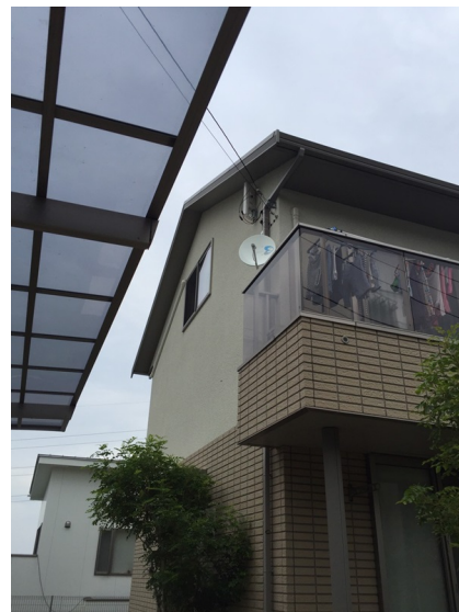
逗子市沼間 一建設様物件 垂直偏波受信 壁面取付 デザインアンテナとBS/CSアンテナ 工事
