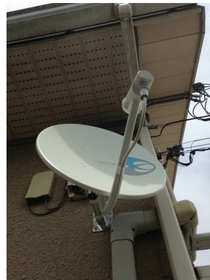
鎌倉市梶原 壁面取付 BSアンテナ工事
