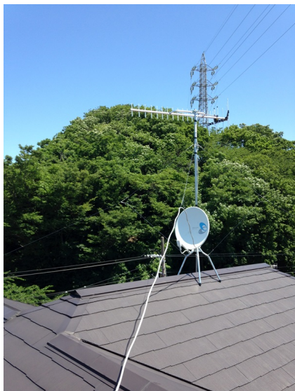
鎌倉市玉縄 垂直偏波受信 地デジアンテナとBSアンテナ屋根上工事
