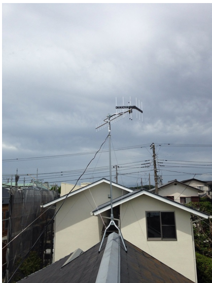
鎌倉市稲村ヶ崎 垂直偏波受信 地デジアンテナ屋根上工事
