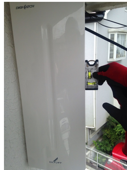
鎌倉市今泉 壁面取付 デザインアンテナ工事
