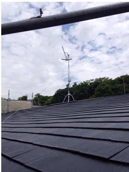
鎌倉市七里ヶ浜東 垂直偏波受信 地デジアンテナ屋根上工事
