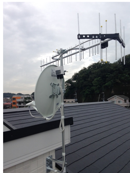
鎌倉市台 垂直偏波受信 壁面取付 地デジアンテナとBSアンテナ工事
