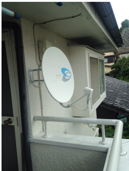
鎌倉市今泉 壁面取付 BSアンテナ工事
