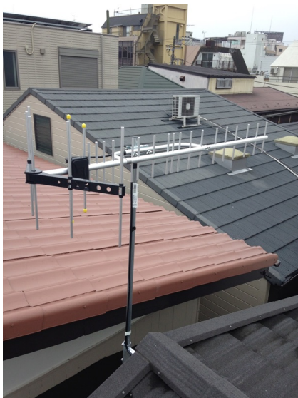
鎌倉市大船 垂直偏波受信 壁面取付 地デジアンテナ工事
