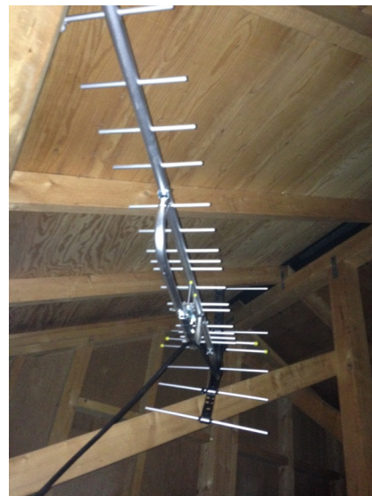
鎌倉市梶原 地デジアンテナ屋根裏工事
