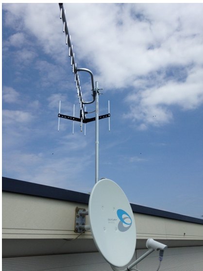
鎌倉市腰越 垂直偏波受信 壁面取付 地デジアンテナとBSアンテナ工事
