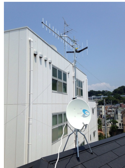
鎌倉市上町屋 地デジアンテナとBSアンテナ屋根上工事
