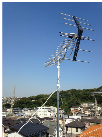
鎌倉市稲村ガ崎 屋根上取付 八木式アンテナ工事
