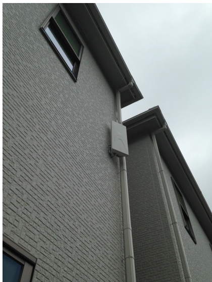
鎌倉市関谷 一建設様物件 壁面取付 デザインアンテナ工事
