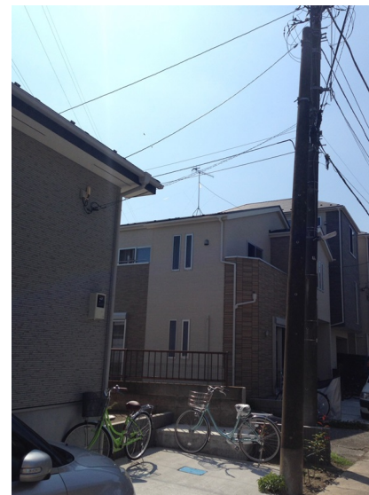
鎌倉市大船 ホームランド様物件 垂直偏波受信 地デジアンテナ工事後の外観
