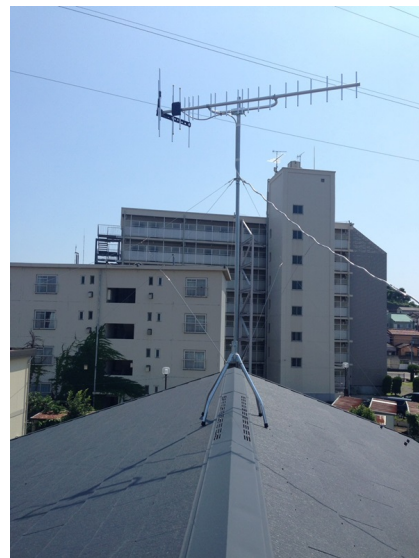
鎌倉市大船 ホームランド様物件 垂直偏波受信 地デジアンテナ屋根上工事
