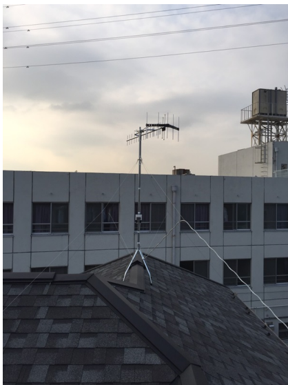
鎌倉市岩瀬 サンケイホーム様物件 垂直偏波受信 地デジアンテナ屋根上工事
