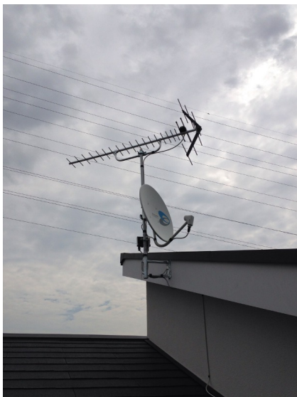
鎌倉市寺分 破風板取付 地デジアンテナとBSアンテナ工事
