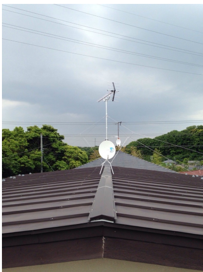
鎌倉市今泉台 地デジアンテナとBSアンテナ屋根上工事
