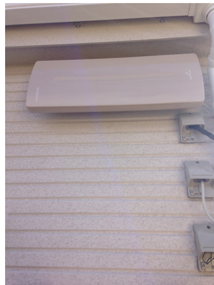
鎌倉市腰越 タクトホーム様物件 垂直偏波受信 壁面取付 デザインアンテナ工事
