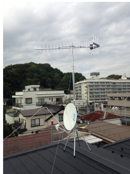
鎌倉市台 垂直偏波受信 地デジアンテナとBSアンテナ屋根上工事
