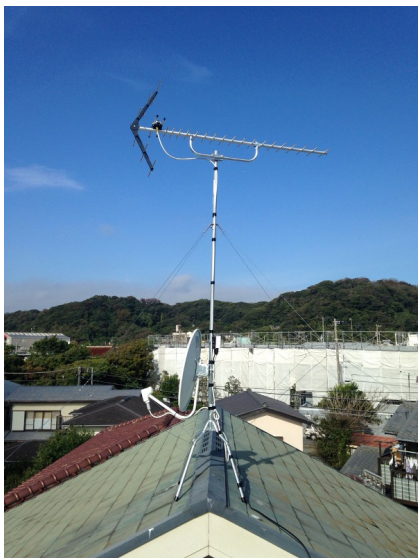
鎌倉市由比ガ浜 地デジアンテナとBSアンテナ屋根上工事
