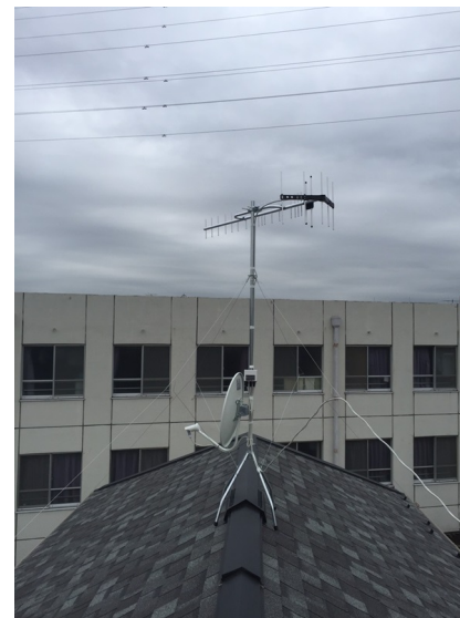
鎌倉市岩瀬 サンケイホーム様物件 垂直偏波受信 地デジアンテナとBSアンテナ屋根上工事
