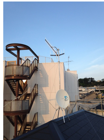
鎌倉市上町屋 一建設様物件 垂直偏波受信 地デジアンテナとB S アンテナ屋根上工事
