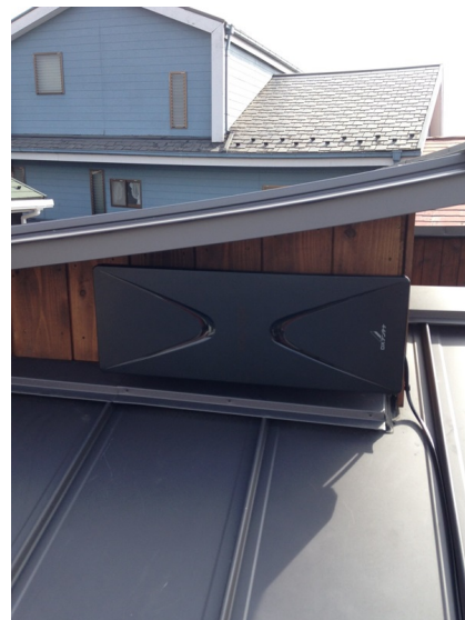
鎌倉市山ノ内 池田工務店様物件 垂直偏波受信 壁面取付 デザインアンテナ工事
