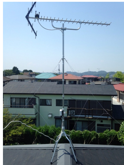
鎌倉市台 古川林業様物件 地デジアンテナ屋根上工事
