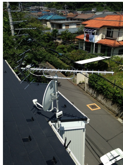
鎌倉市今泉台 高野建築様物件 壁面取付 地デジアンテナとBSアンテナ工事
