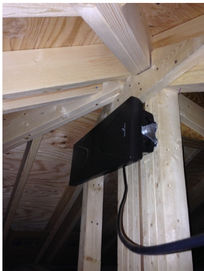
鎌倉市大船 アーネストワン様物件 デザインアンテナの屋根裏設置工事
