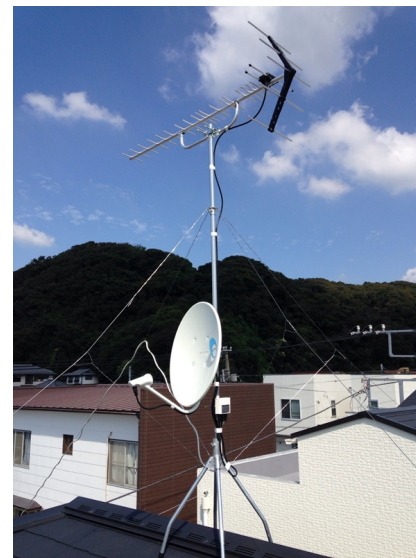
鎌倉市大町 ひかり建設様物件 地デジアンテナとBSアンテナ屋根上工事
