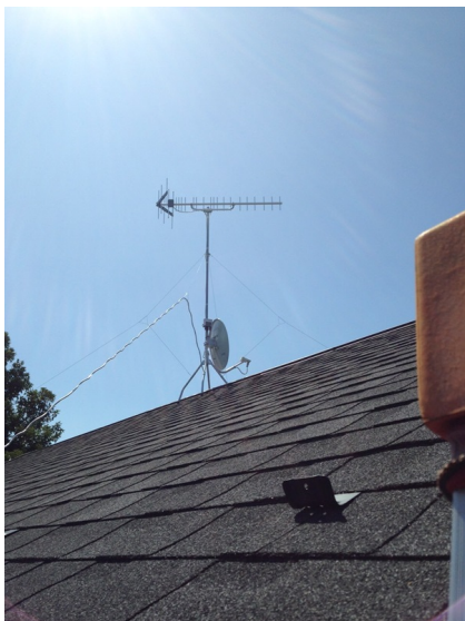
鎌倉市大船 アーネストワン様物件 地デジアンテナとBSアンテナ屋根上工事
