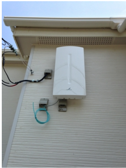
習志野市藤崎 壁面取付 デザインアンテナ工事
