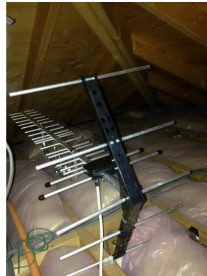
習志野市藤崎 地デジアンテナ屋根裏工事
