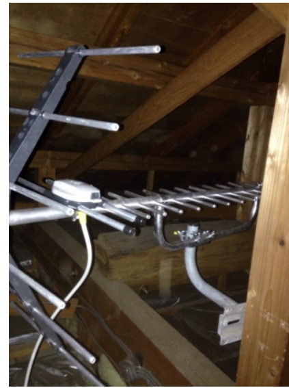
習志野市谷津 地デジアンテナ屋根裏工事
