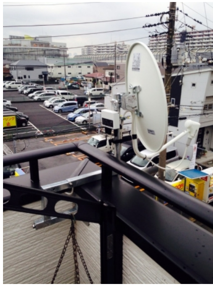
習志野市谷津 BSアンテナ挟み込み工事
