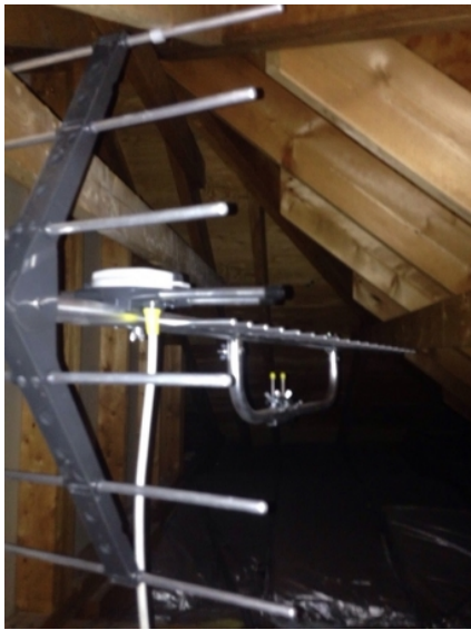
習志野市八津 地デジアンテナ屋根裏工事
