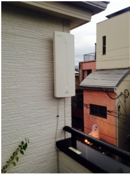
習志野市谷津 壁面取付 デザインアンテナ工事
