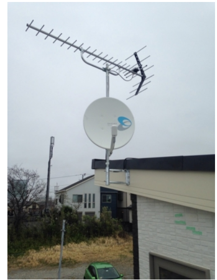
習志野市谷津 アイ・ケーインターナショナル様ご物件 壁面取付 地デジアンテナとBSアンテナ工事
