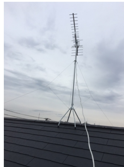
習志野市鷺沼台 桧屋住宅様ご物件 地デジアンテナ屋根上工事
