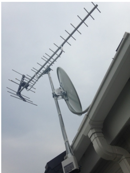
習志野市新栄 アイダ設計様ご物件 壁面取付 地デジアンテナとBSアンテナ工事
