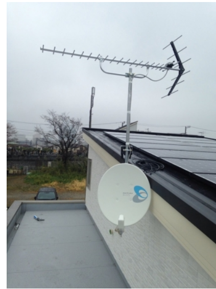
習志野市谷津 アイ・ケーインターナショナル様ご物件 壁面取付 地デジアンテナとBSアンテナ工事
