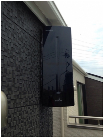
習志野市藤崎 レオハウジング様ご物件 壁面取付 デザインアンテナ工事
