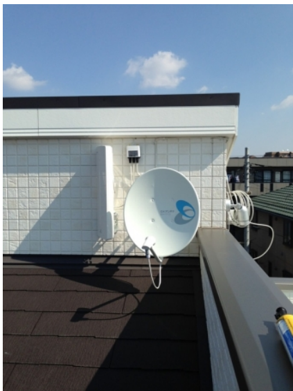
習志野市鷺沼 なのはなハウジング様ご物件 壁面取付 デザインアンテナとBSアンテナ工事
