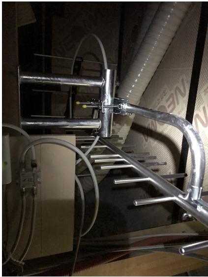
習志野市屋敷 東海住宅様ご物件 屋根裏設置 地デジアンテナ工事
