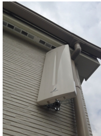
習志野市藤崎 飯田産業様ご物件 壁面取付 デザインアンテナ工事
