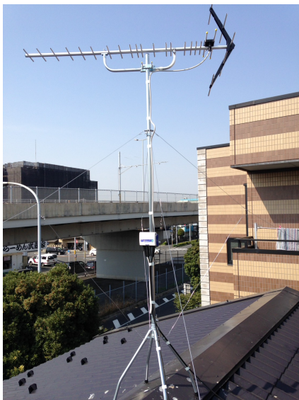
習志野市谷津 屋根上設置 八木式アンテナ工事
