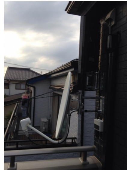
習志野市袖ヶ浦 アサカワホーム様ご物件 壁面取付 デザインアンテナとBSアンテナ工事
