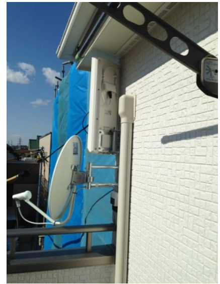
習志野市藤崎 一建設様ご物件 壁面取付 デザインアンテナとB Sアンテナ工事
