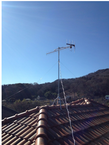
厚木市飯山 垂直偏波受信 地デジアンテナ屋根上工事
