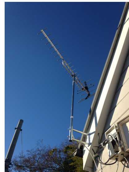
厚木市関口 壁面取付 地デジアンテナ工事
