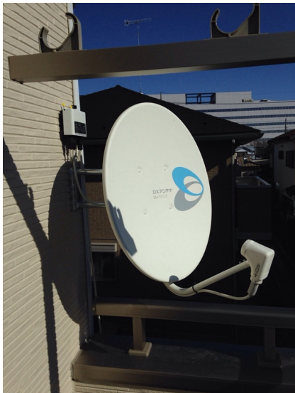
厚木市岡田 壁面取付 BSアンテナ工事
