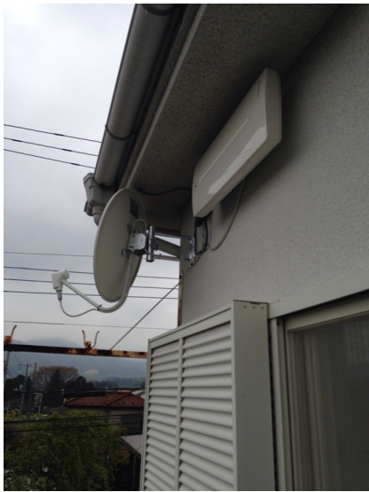
厚木市蔦尾 壁面取付 デザインアンテナとBSアンテナ工事
