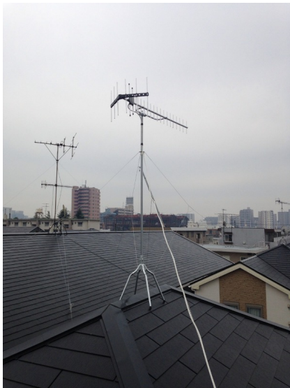
厚木市水引 垂直偏波受信 地デジアンテナ屋根上工事
