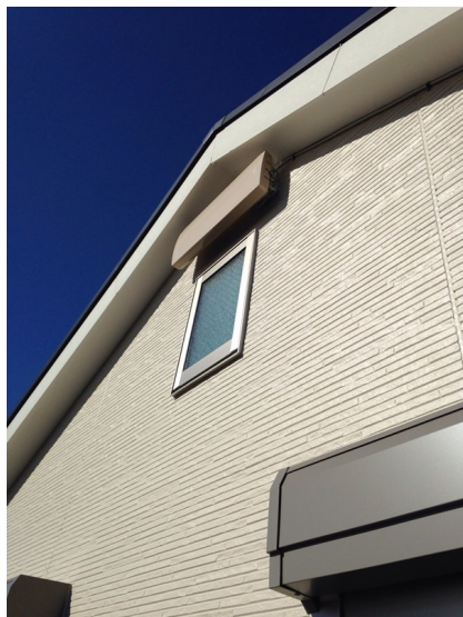
厚木市岡田 壁面取付 デザインアンテナ工事
