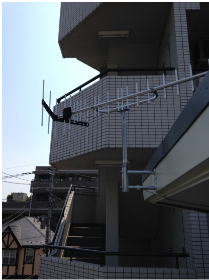
厚木市旭町 一条工務店様ご物件 垂直偏波受信 壁面取付 地デジアンテナ工事
