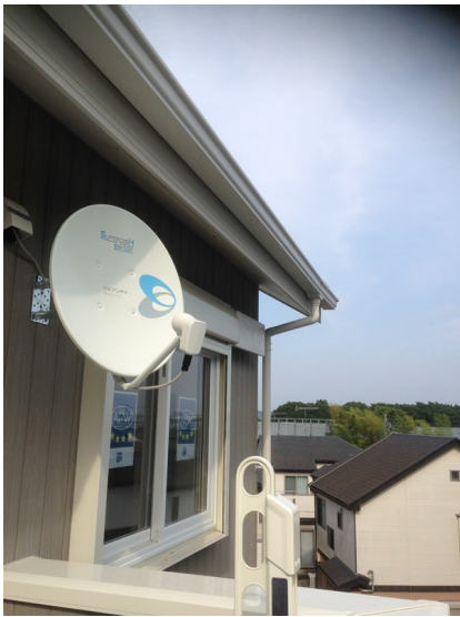
厚木市下依知 ジューテックホーム様ご物件 壁面取付 BSアンテナ工事
