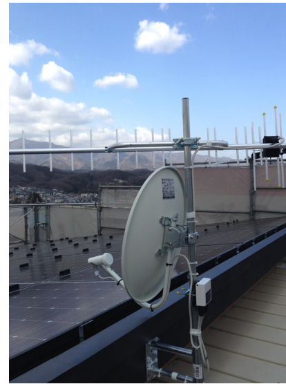
厚木市温水 一条工務店様ご物件 壁面取付 垂直偏波受信 地デジアンテナ工事とBSアンテナ工事
