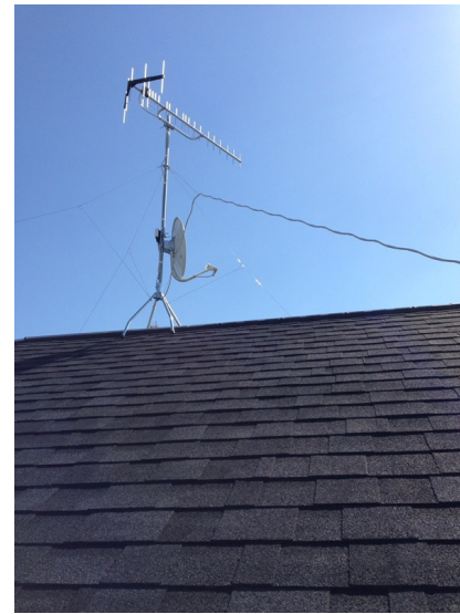
厚木市緑ヶ丘 アイディホーム様ご物件 垂直偏波受信 地デジアンテナとBSアンテナ屋根上工事
