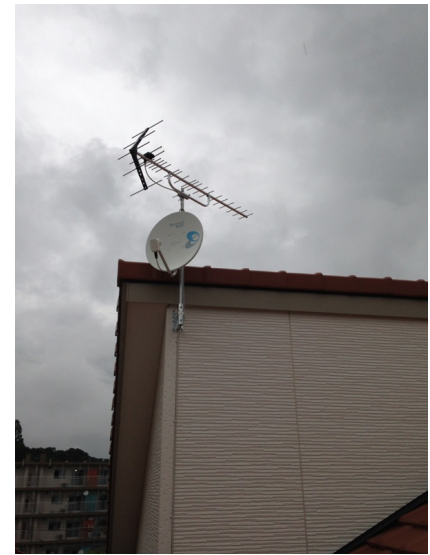
厚木市緑ヶ丘 アイダ設計様ご物件 壁面取付 地デジアンテナとBSアンテナ工事
