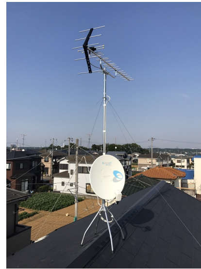
厚木市上依知 アーネストワン様ご物件 地デジアンテナとBSアンテナ屋根上工事
