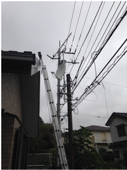
厚木市森の里 スッキリポール設置 地デジアンテナとBSアンテナ工事
