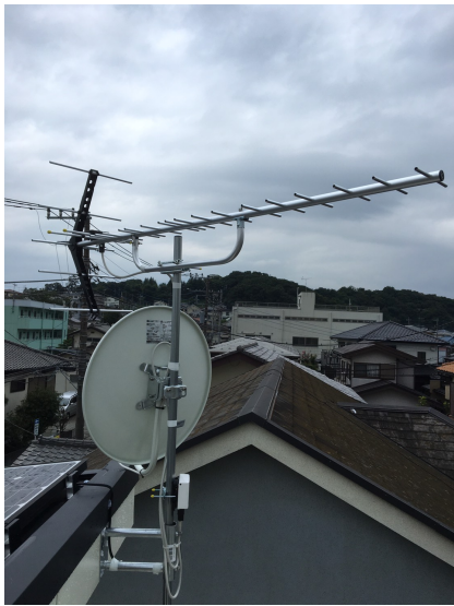
厚木市林 一条工務店様ご物件 地デジアンテナとBSアンテナ工事
