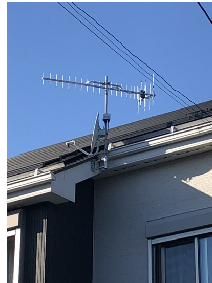
厚木市林 破風取り付け 八木式アンテナとBS/CSアンテナ設置工事
