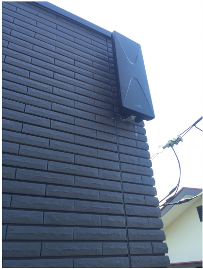
厚木市温水 一条工務店様ご物件 壁面取り付け デザインアンテナ工事
