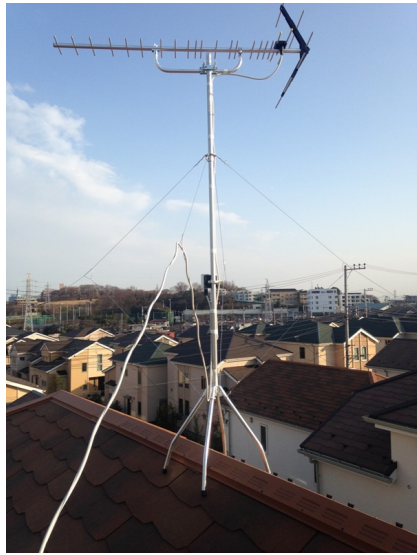
厚木市温水西 イトーピアホーム様ご物件 地デジアンテナ屋根上工事
