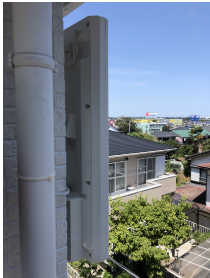
厚木市山際 デザインアンテナ壁面取り付け
