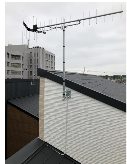
厚木市飯山 大勢ハウジング様ご物件 八木式アンテナ壁面取り付け
