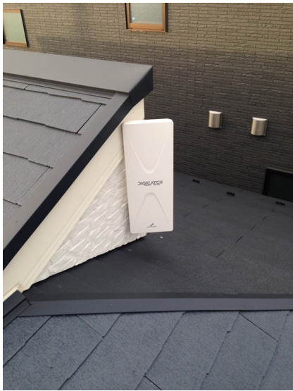
厚木市戸室 若林工務店様ご物件 壁面取付 デザインアンテナ工事
