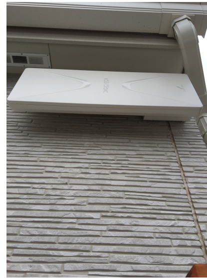
厚木市鷺尾 壁面取付 デザインアンテナ工事
